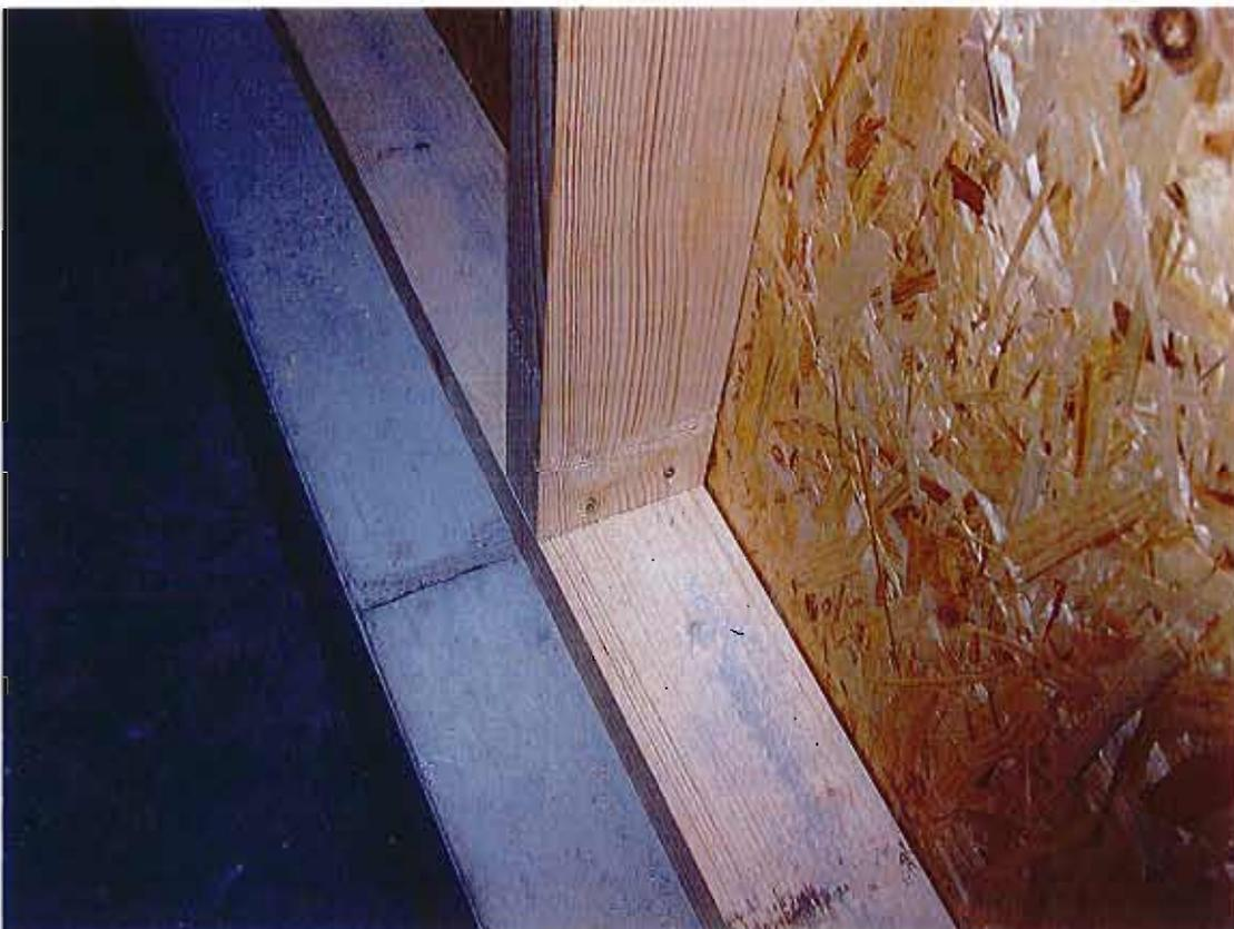
**Détail de la fixation entre les montants et les lisses de l'ossature primaire**
