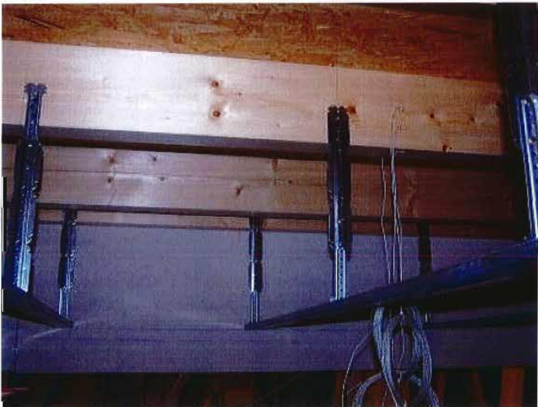
Vues de détail de l'ossature du plafond suspendu
