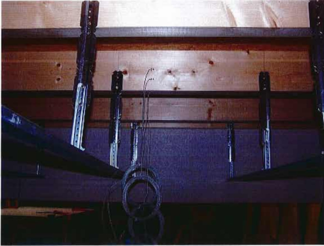
Vues de détail de l'ossature du plafond suspendu
