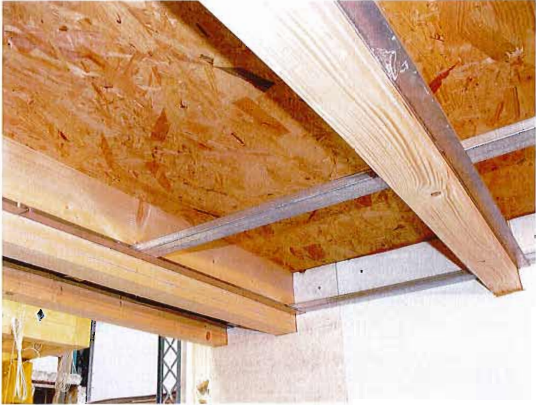
Vues de détails de la mise en œuvre de l'ossature entre les solives
