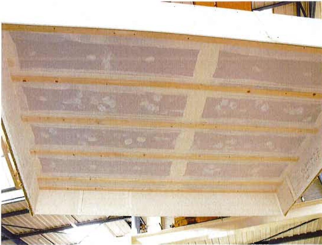
Vue de la face exposée avant la réalisation de l'essai
