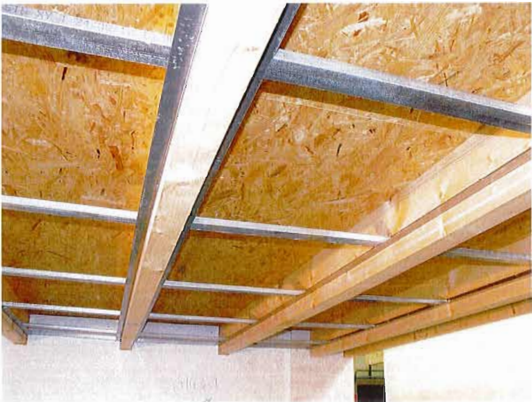
Vues de détails de la mise en œuvre de l'ossature entre les solives
