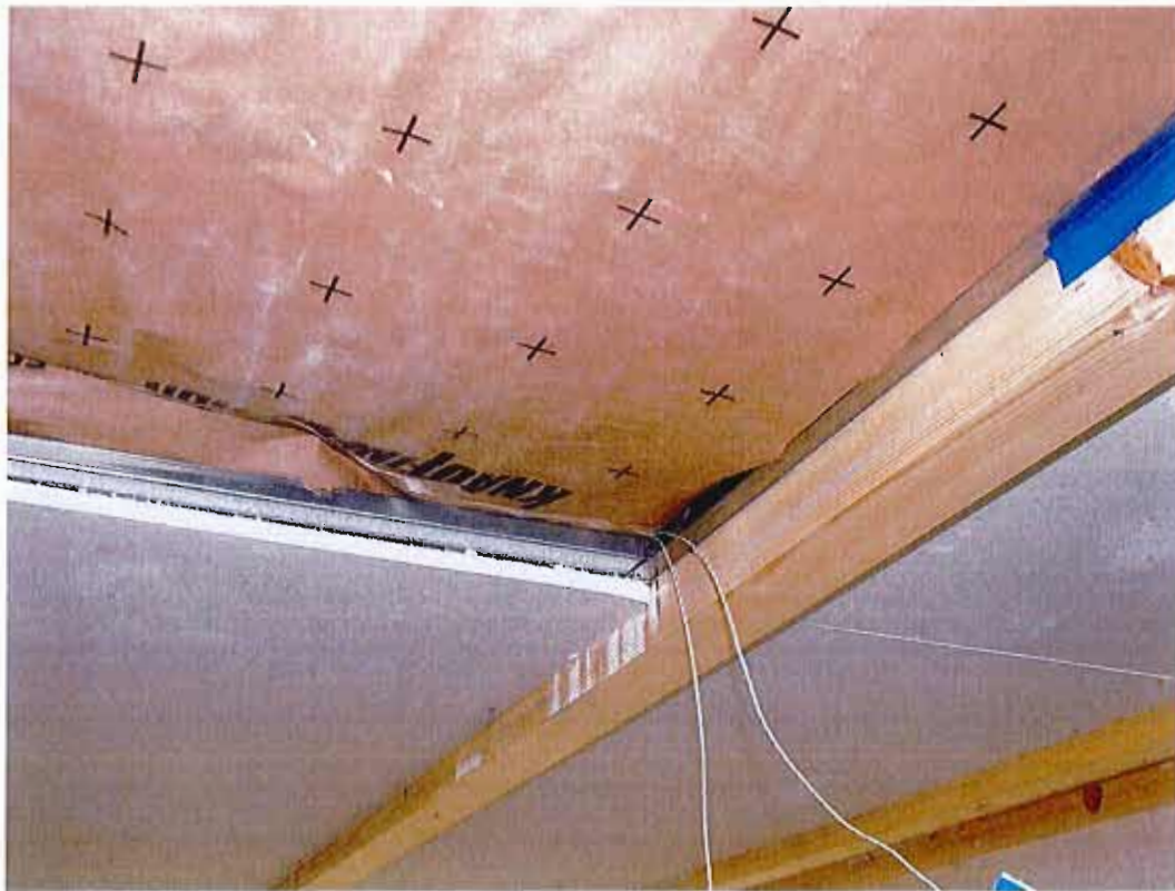
Vues de détail de la mise en œuvre des plaques (1 er peau montée)
