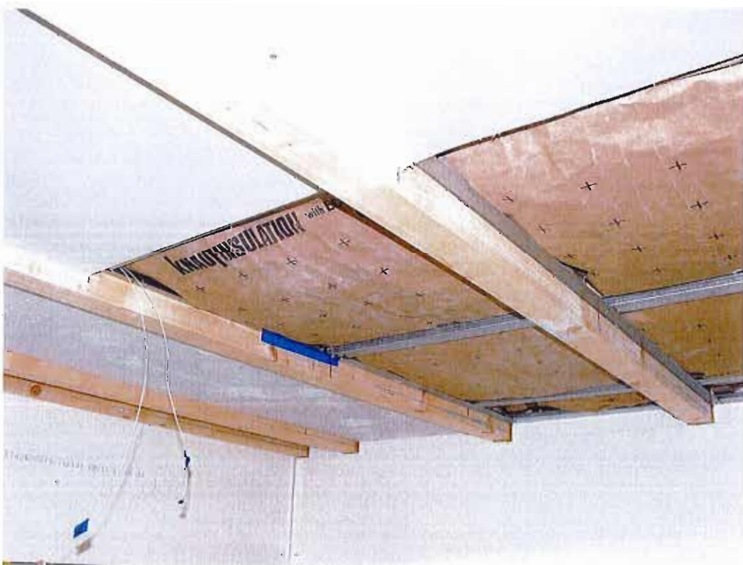
Vues de détail de la mise en œuvre des plaques (1 er peau montée)
