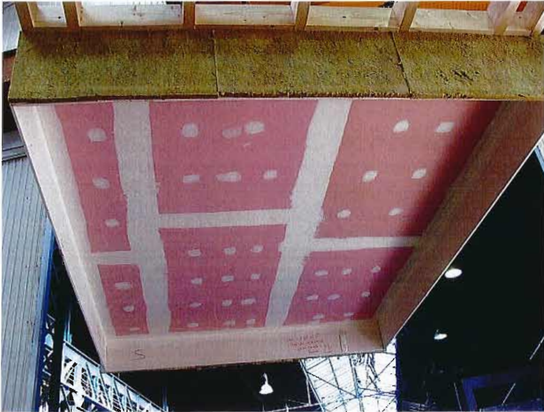
Vus de la face exposée avant la réalisation de l'essai
