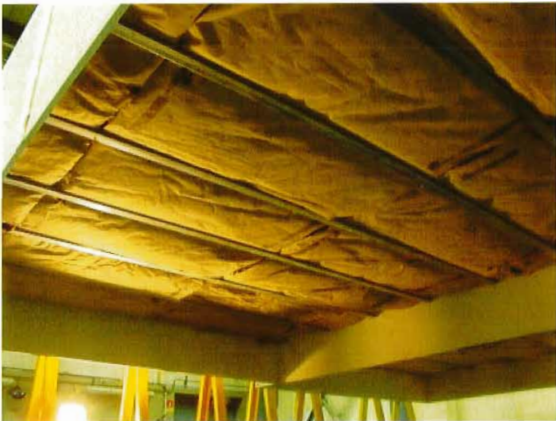
Vue de détail de la mise œuvre de l'isolant
