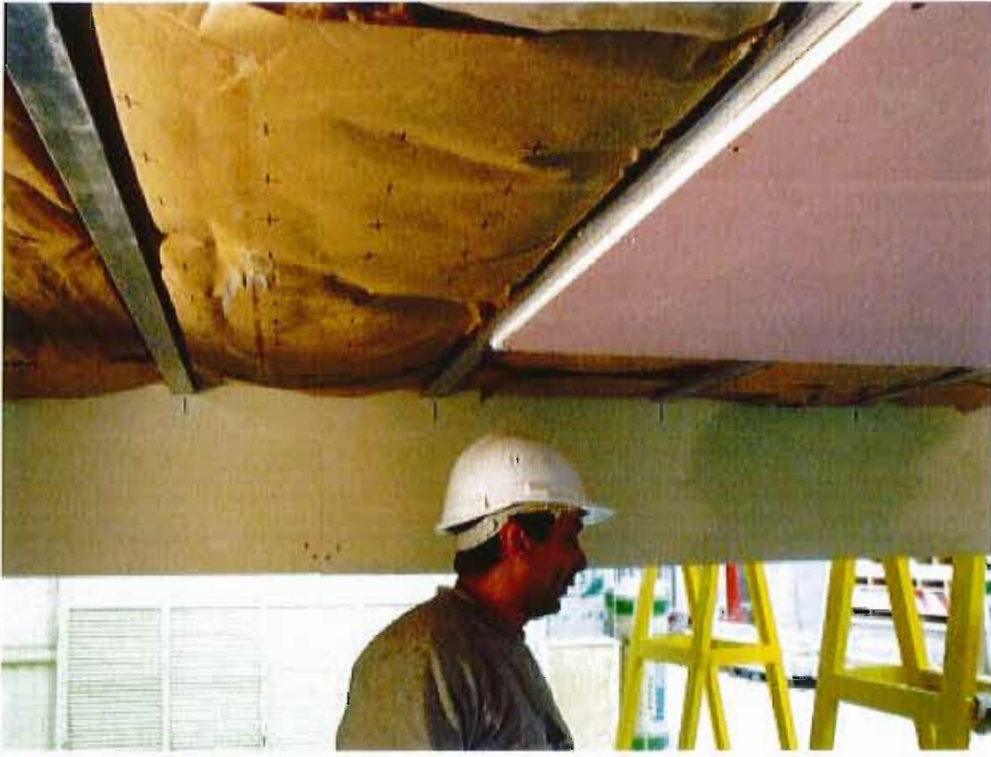
Vues de détail de l'ossature du plafond suspendu
