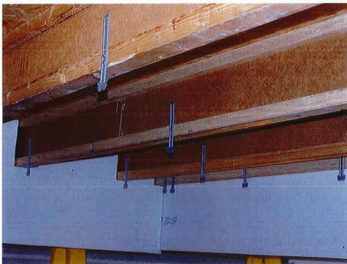
Vue de détail de la mise en œuvre des suspentes
