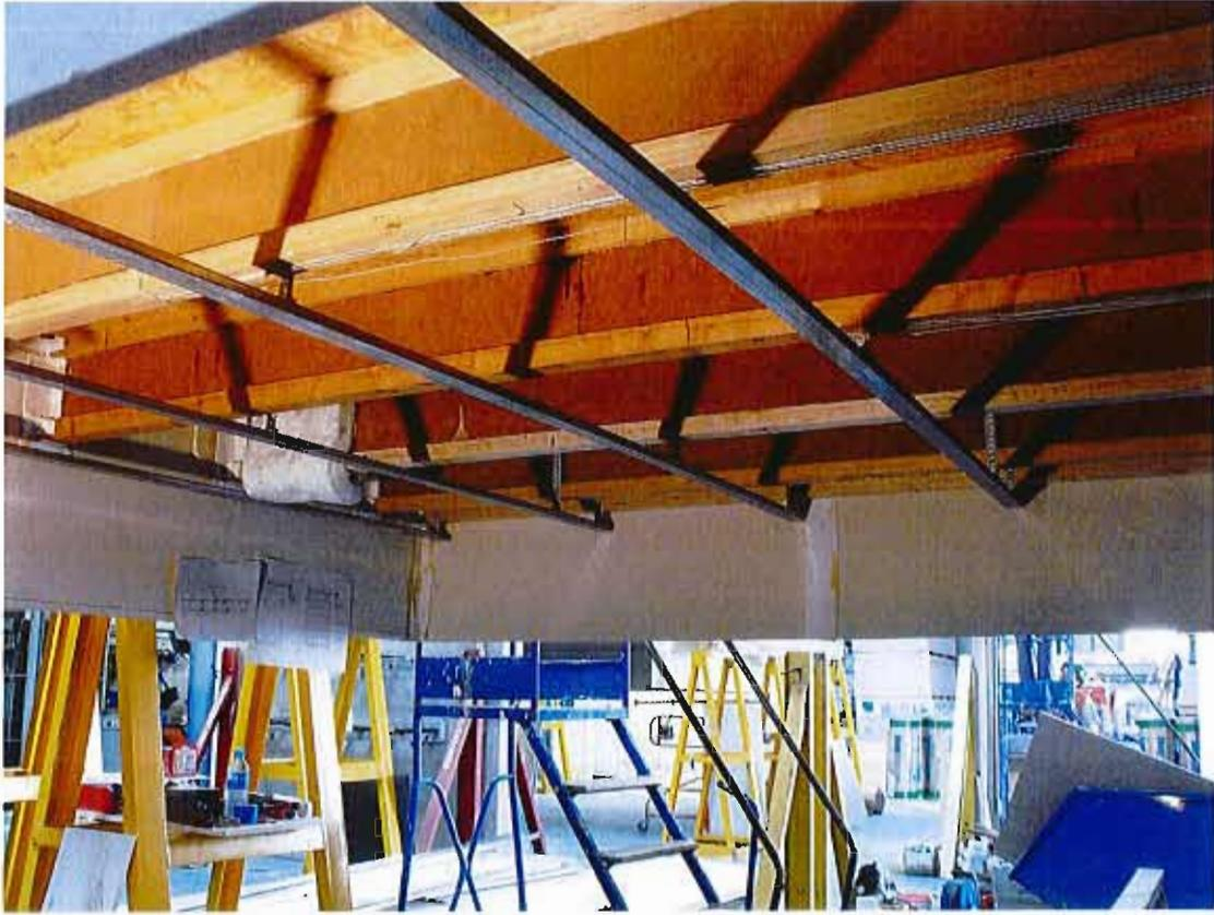
Vue de détail de l'ossature et des fourrures
