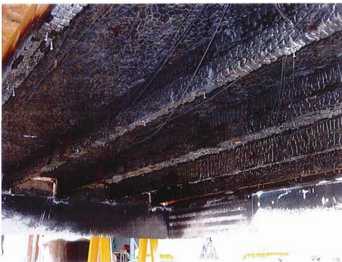
Vue de détail de la face exposée à 20 minutes d'essai
