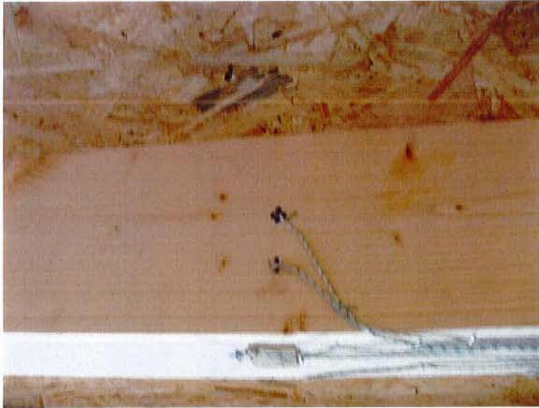
Vue de détail d'une solive du plancher de référence et de son instrumentation
