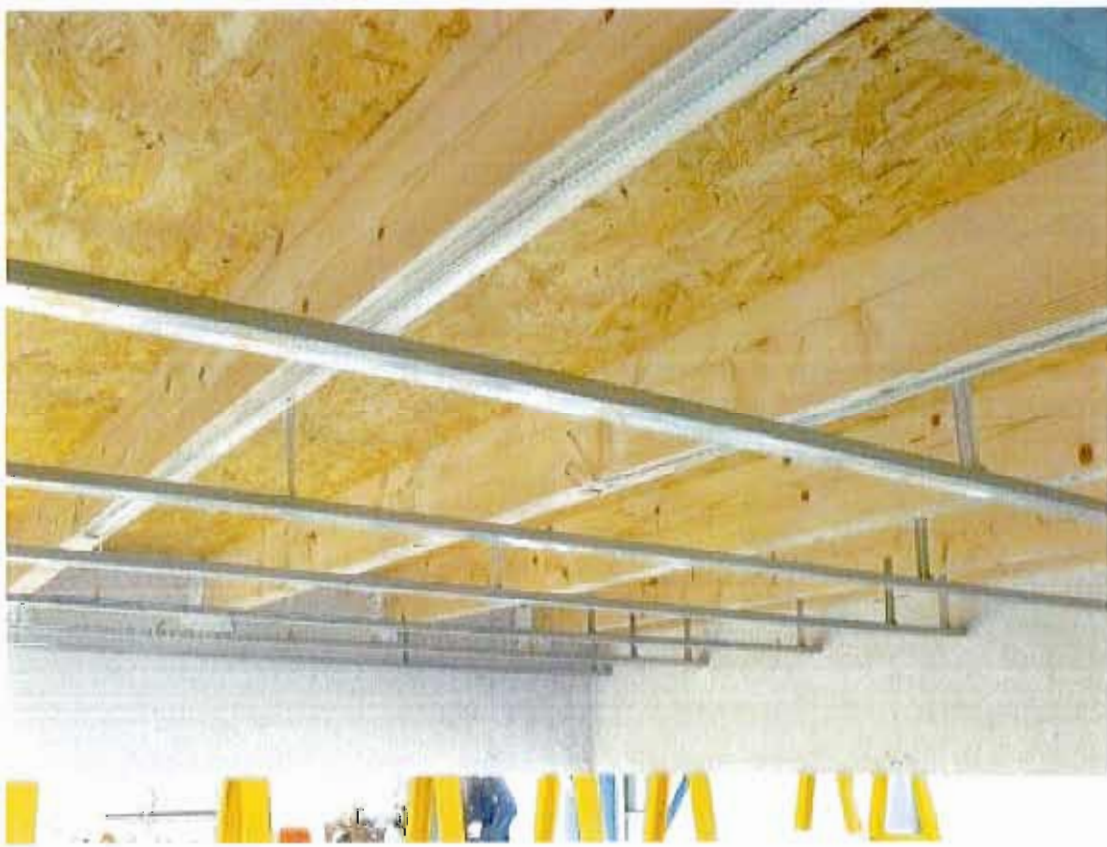
Vue de détail de l'ossature
