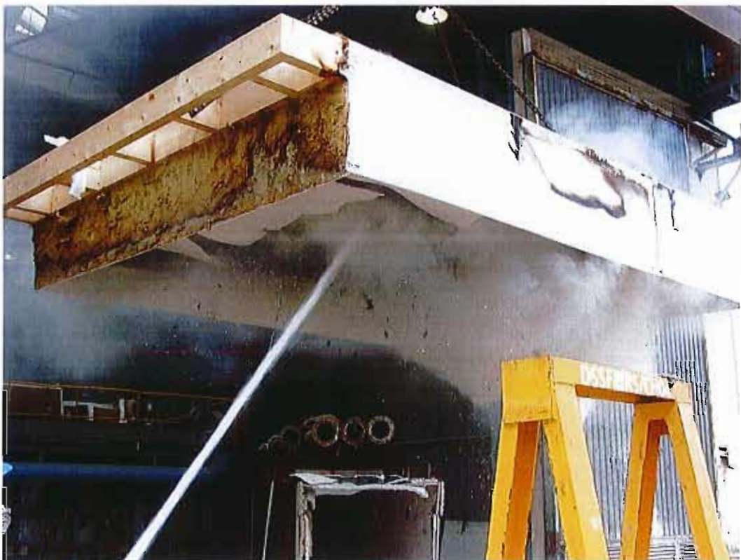
Vue de détail de l'extinction de l'inflammation
