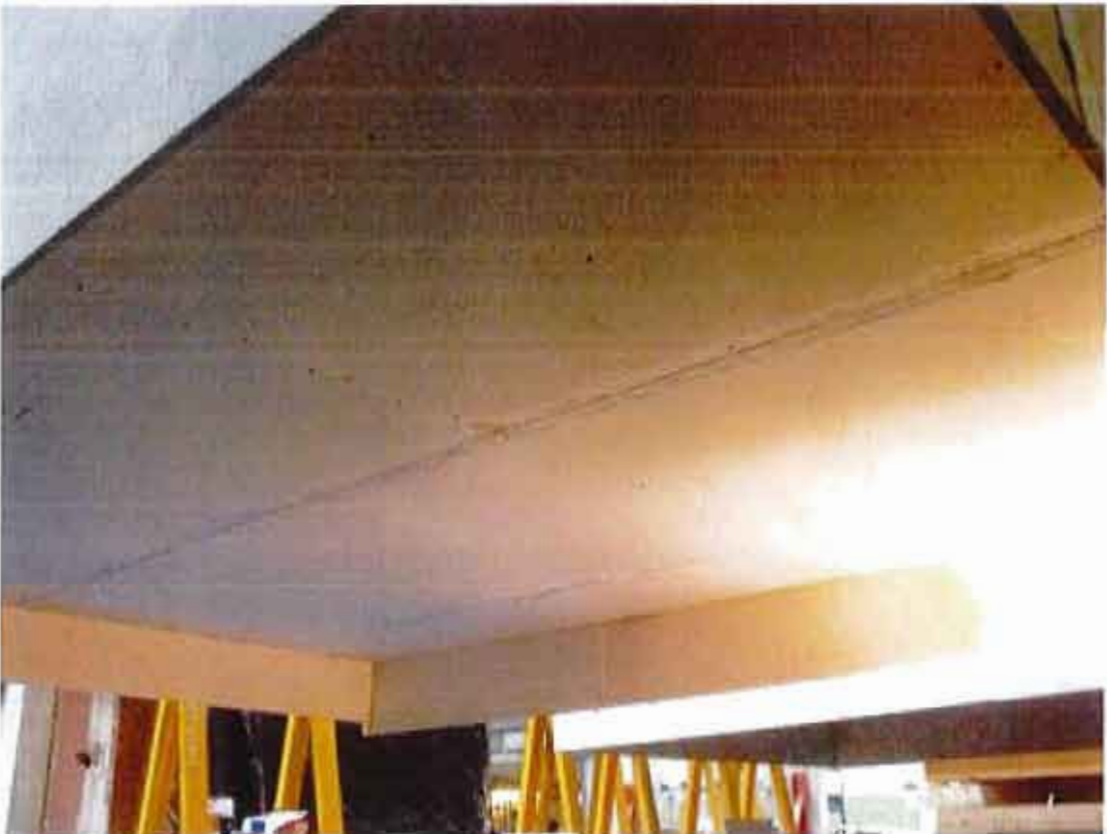
Vue d'ensemble avant la réalisation des bandes à joints
