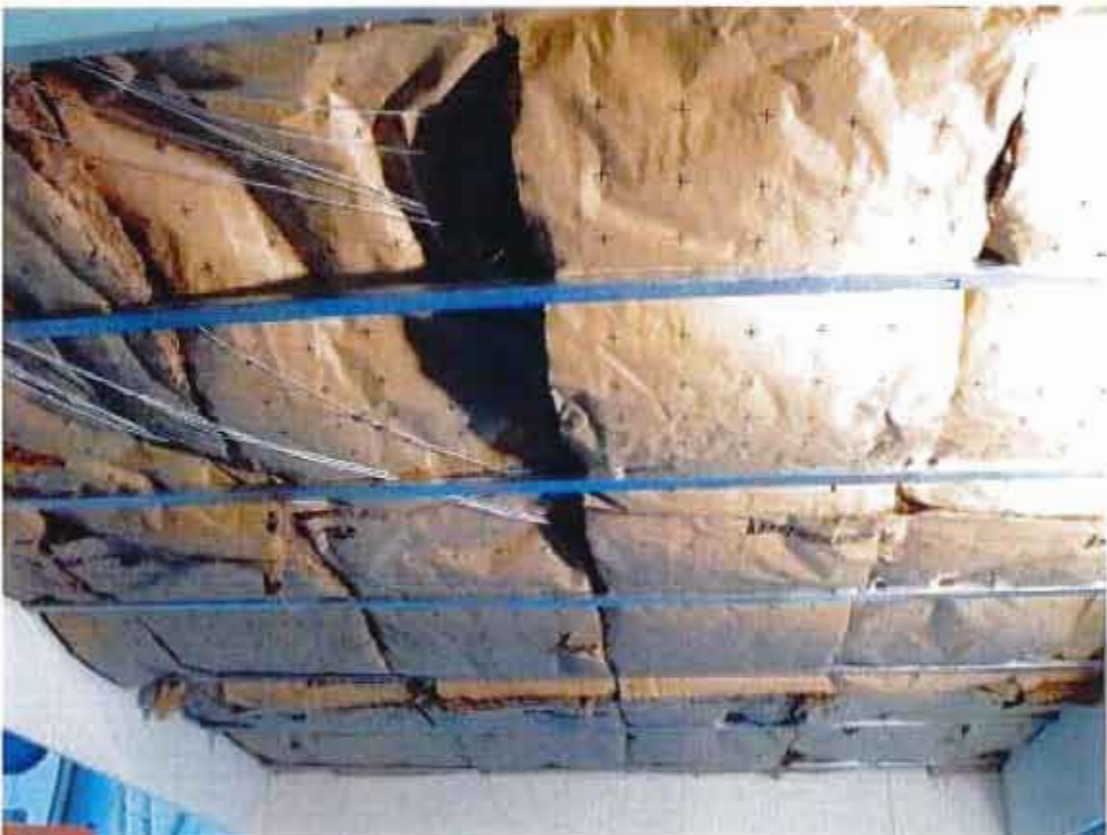
Vue d'ensemble de la mise en œuvre de l'isolant
