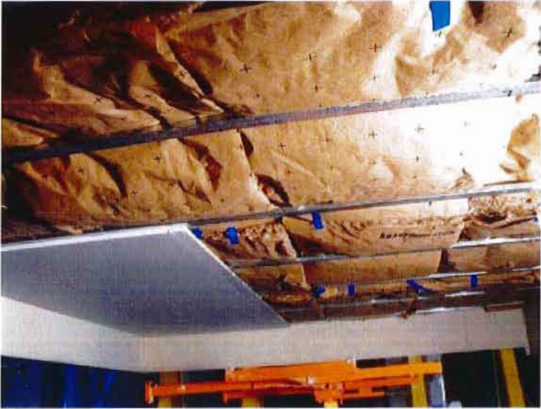
Vue de détail de la pose des plaques
