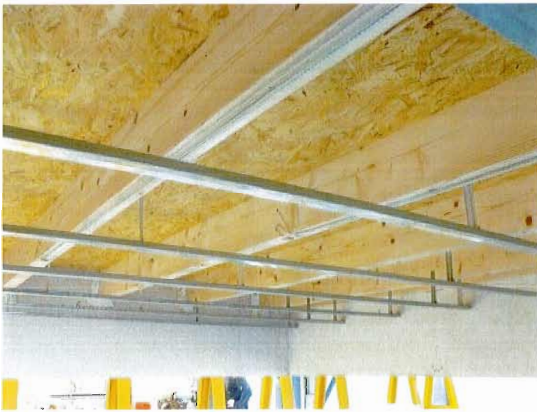
Vue de détail de l'ossature
