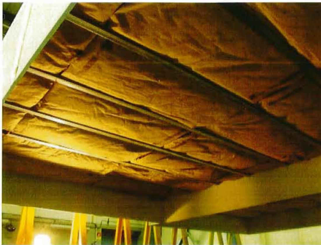
Vue de détail de l'isolant mis en œuvre
