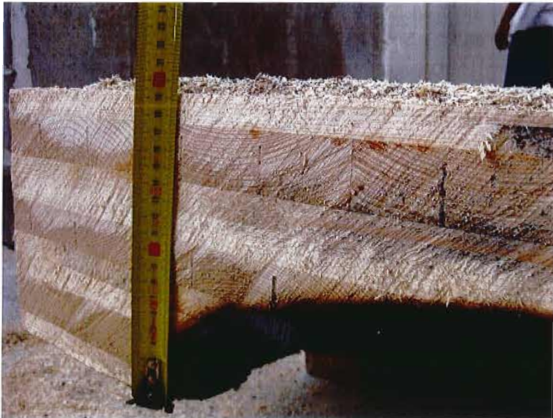
Vue de détail de l'épaisseur de bois sain à proximité des appuis après la réalisation de l'essai
