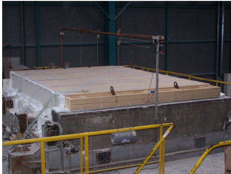
Figure 7 : Photographie du plancher installé sur le four
