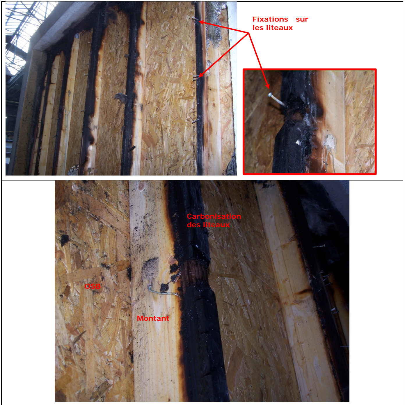
Figure 22 : Photographies des montants, tasseaux et des fixations après l'essai
