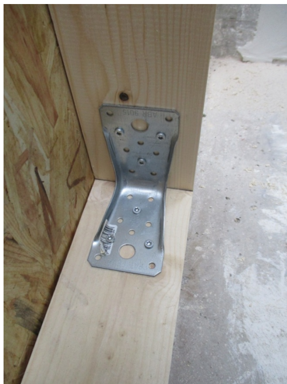
Détail d'une équerre de liaison
