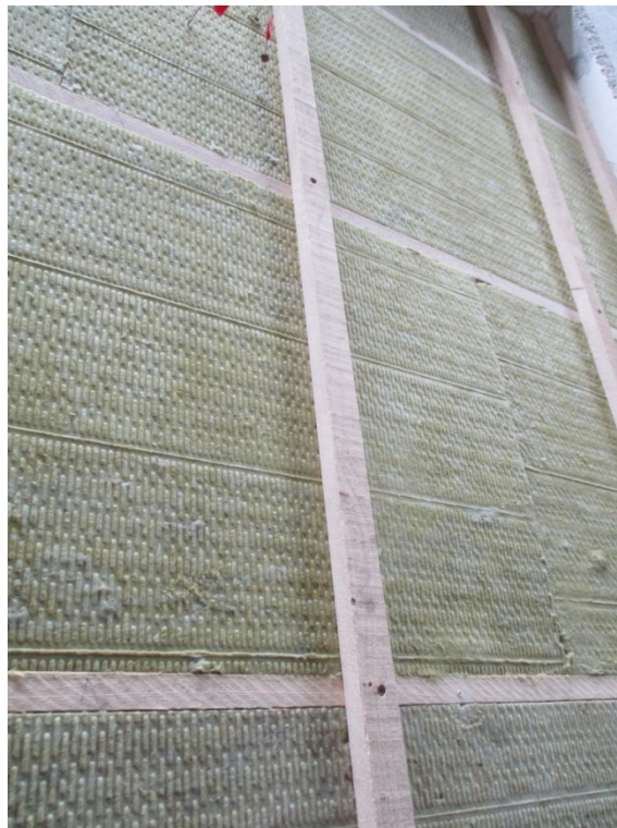
Détail de la fixation des tasseaux support
