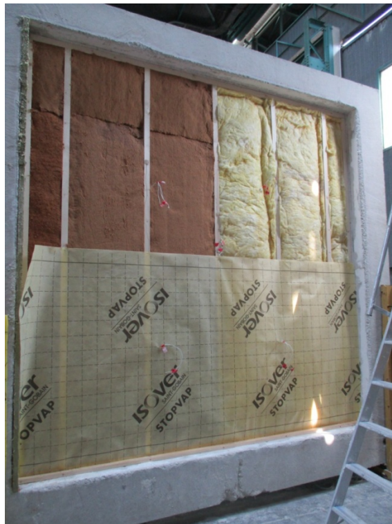
Mise en œuvre du pare-vapeur
