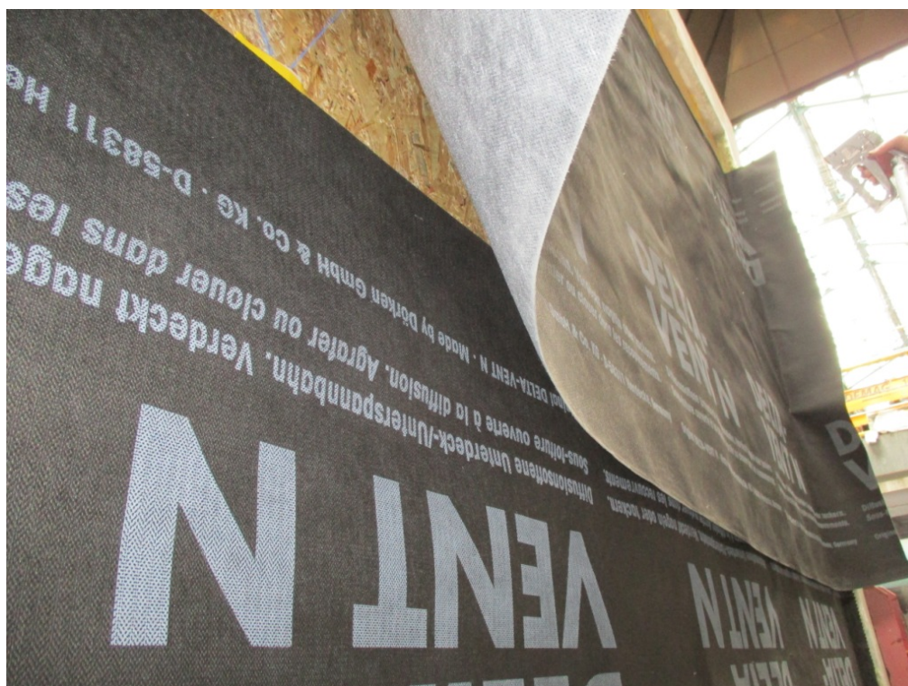
Détail du recouvrement d'un lé
