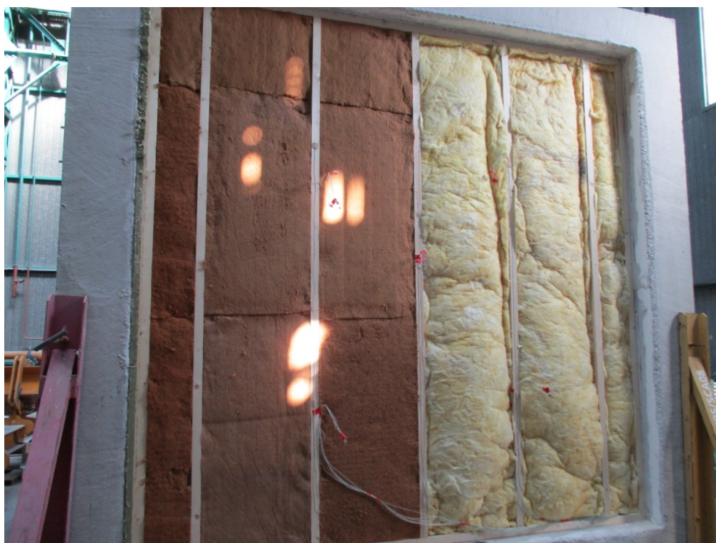
Vue d'ensemble de l'isolation de la cloison
