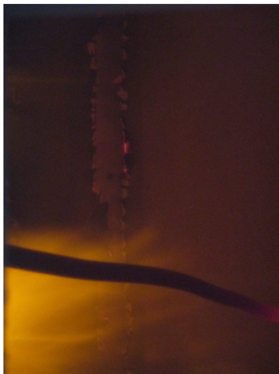
Destruction partielle des enduits de finition et d'une bande à joint à t = 08 [min] 00 [s]
