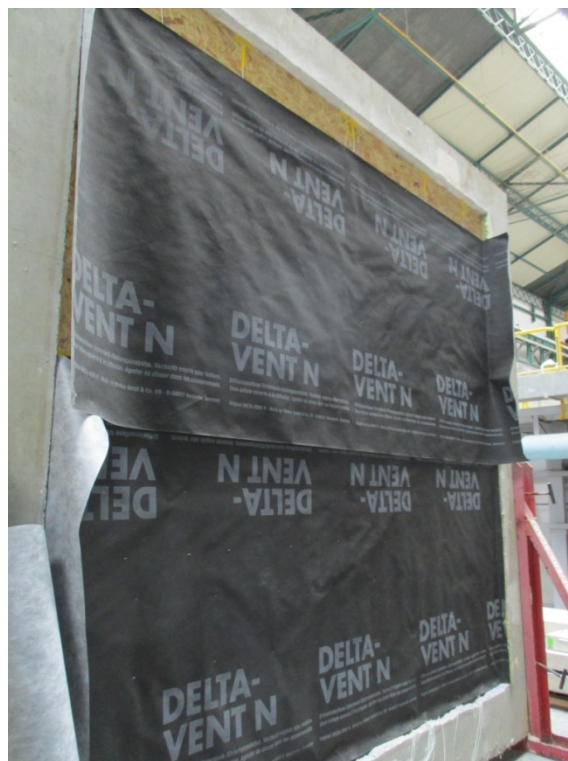
Mise en œuvre du pare-pluie
