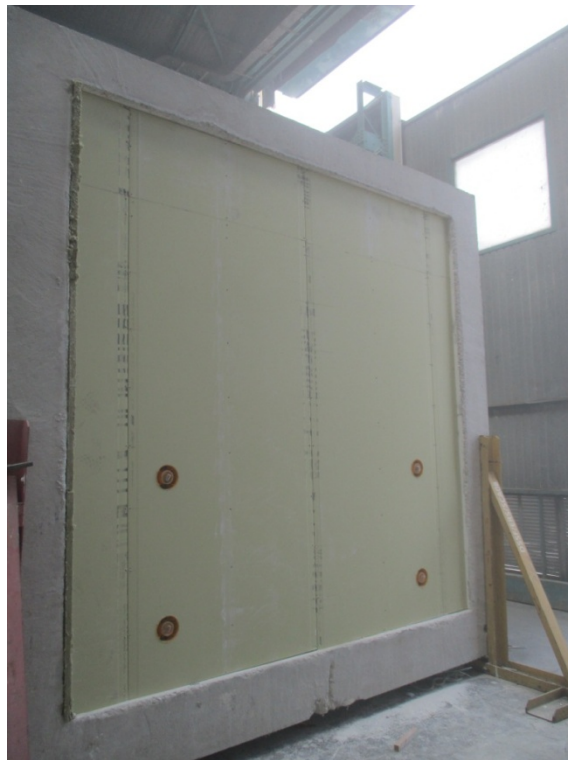
Mise en œuvre de la 2 nde peau du parement intérieur
