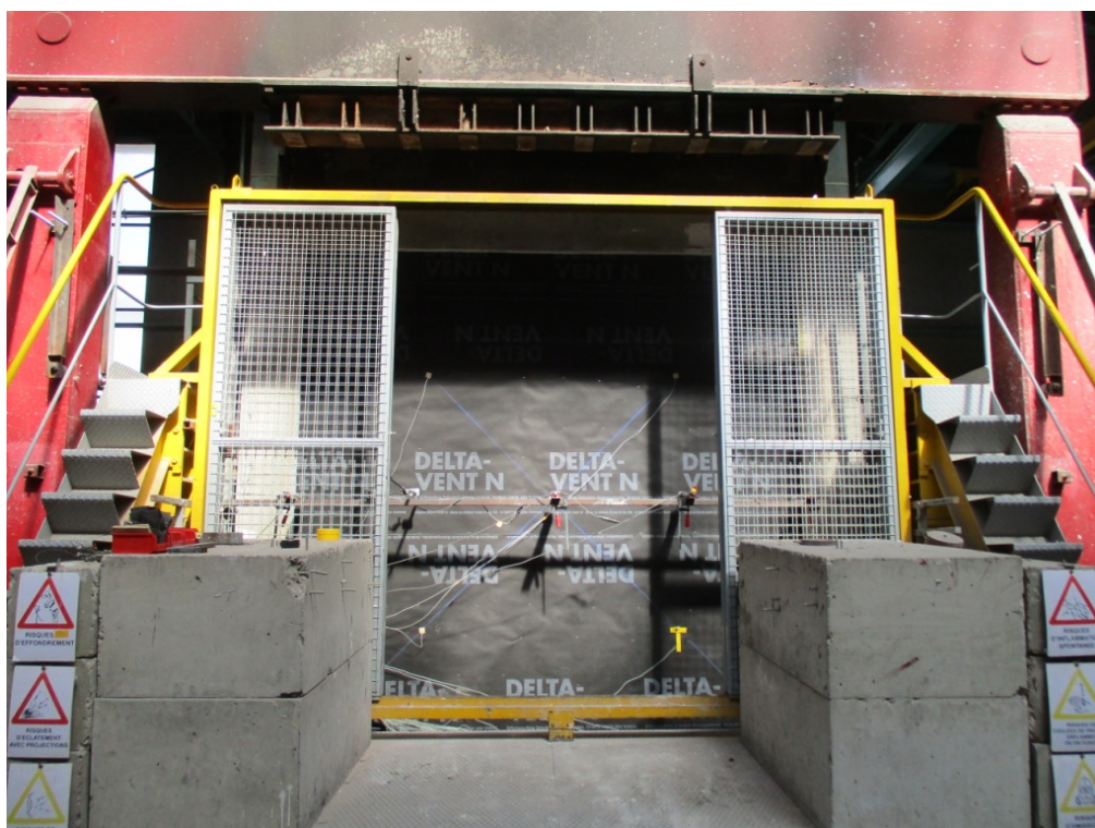
Vue d'ensemble de la face non exposée à t = 20 [min] 00 [s]
