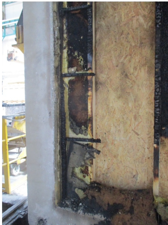
Vue d'ensemble de la 1 ère travée côté bord libre
