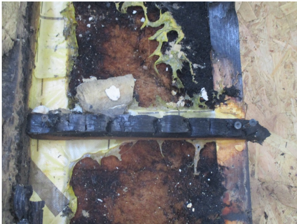
Détail d'un morceau de contre-ossature restant
