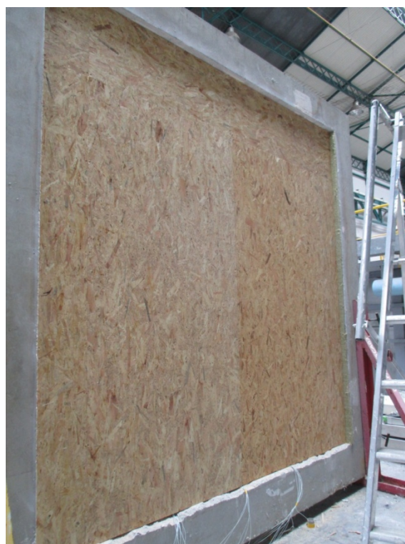
Vue d'ensemble du parement extérieur
