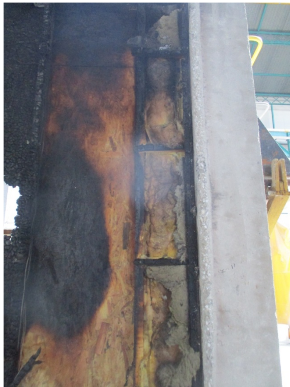
Vue d'ensemble de la 1 ère travée côté bord fixe
