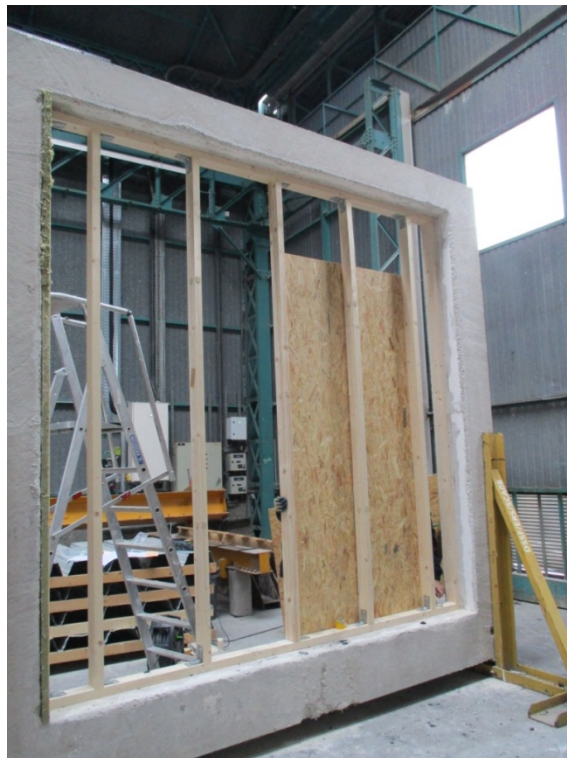
Vue d'ensemble de l'ossature de la cloison
