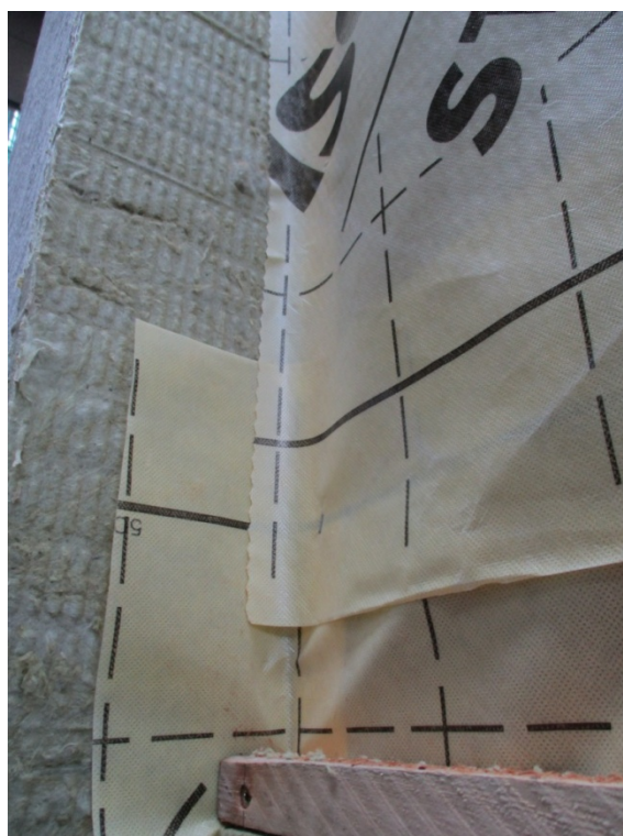
Détail du recouvrement d'un lé
