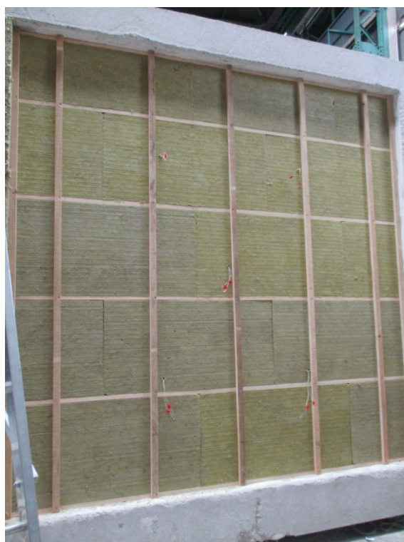
Vue d'ensemble de l'isolation intérieure, de la contre-ossature intérieure et des tasseaux support
