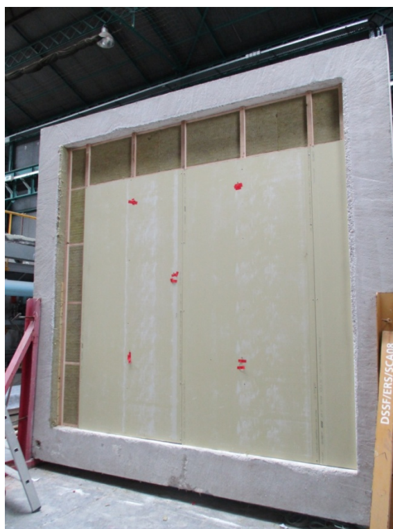
Mise en œuvre de la 1 ère peau du parement intérieur
