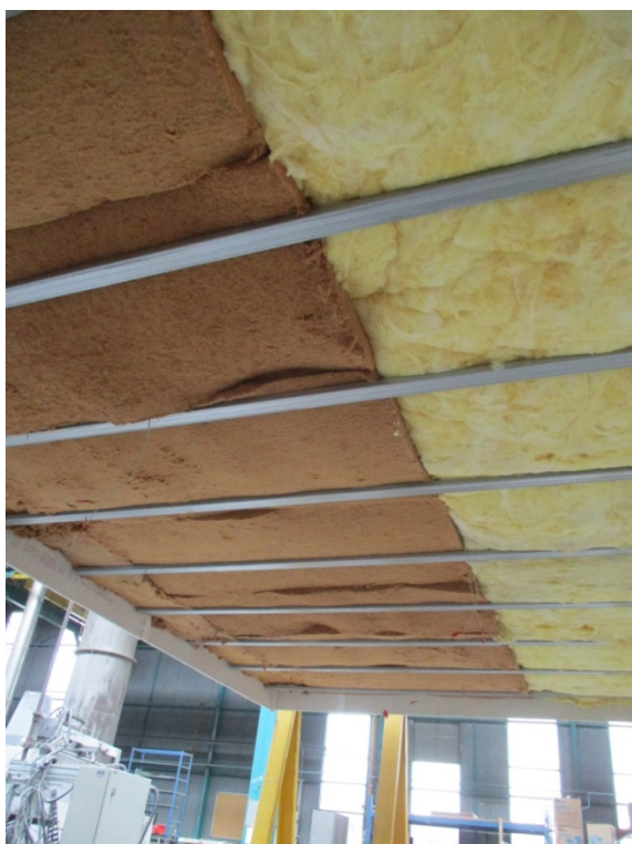
↑ Vue d'ensemble et de détail de l'isolation du plancher ↓
