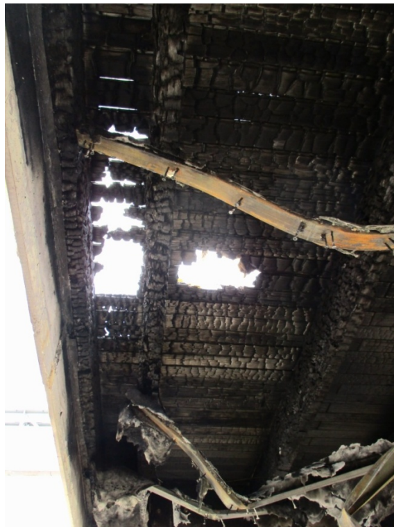
Vue d'ensemble des percements du plancher
