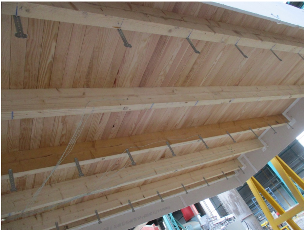
Vue d'ensemble des suspentes de l'ossature métallique
