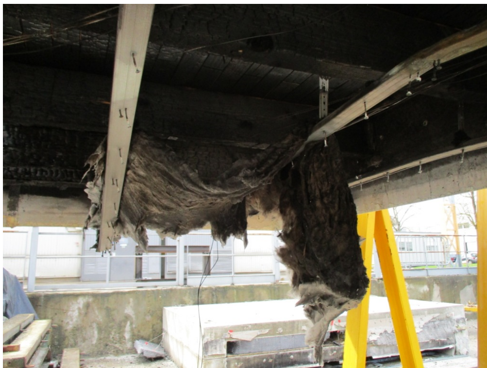
↑ Vues d'ensemble des résidus d'isolation du plancher (laine de verre) ↑
