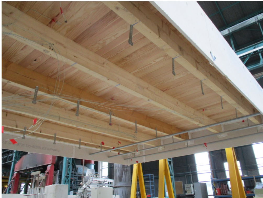
Mise en œuvre des fourrures de l'ossature métallique
