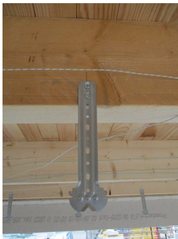
Détail de la mise en œuvre d'une suspente
