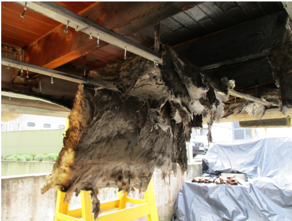
↑ Vues d'ensemble des résidus d'isolation du plancher (laine de verre) ↑
