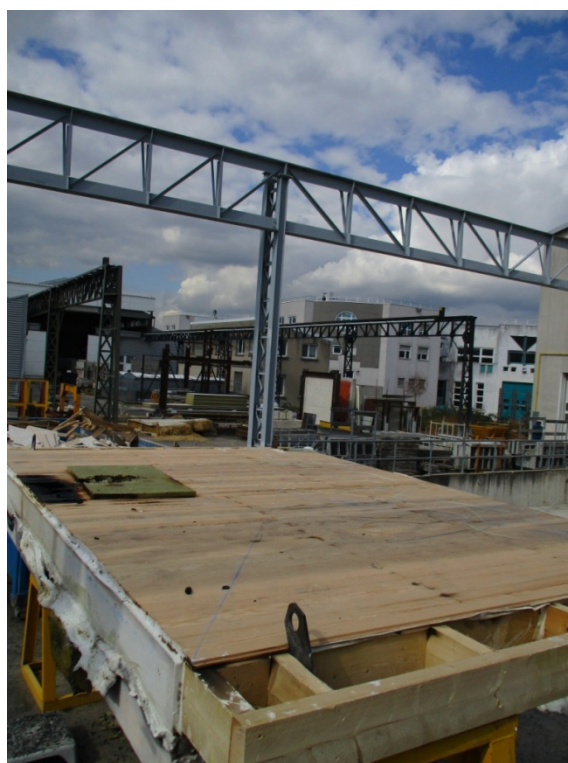
Vue d'ensemble de la face non exposée après refroidissement
