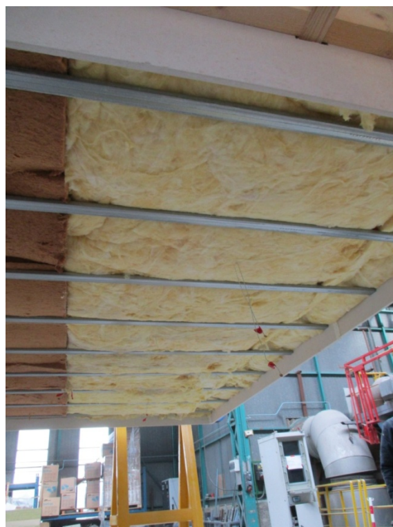
↑ Vue d'ensemble et de détail de l'isolation du plancher ↓
