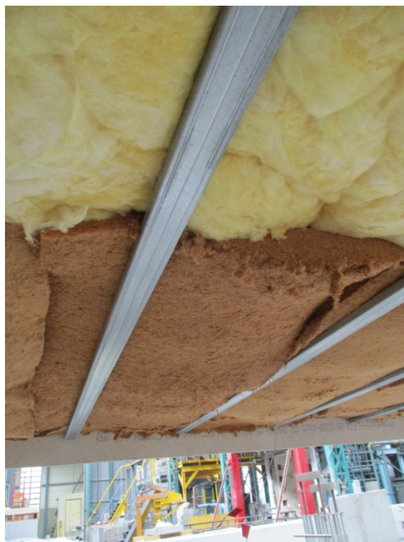
Détail de la mise en œuvre d'un panneau de laine de bois
