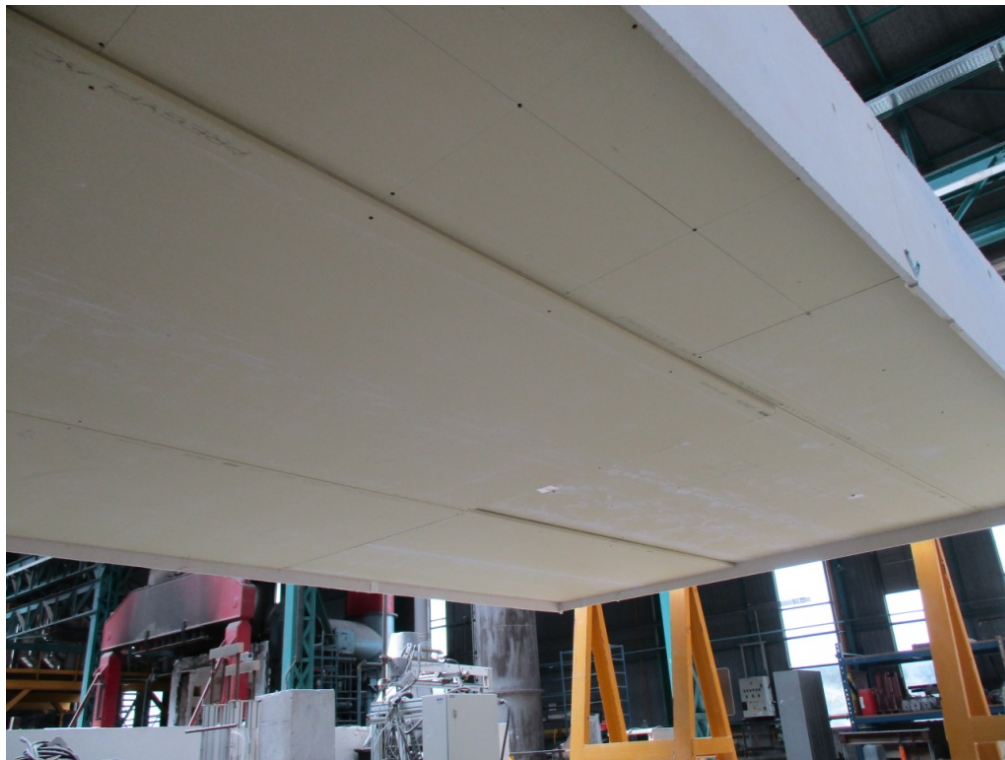
Mise en œuvre de la 2 nd e peau
