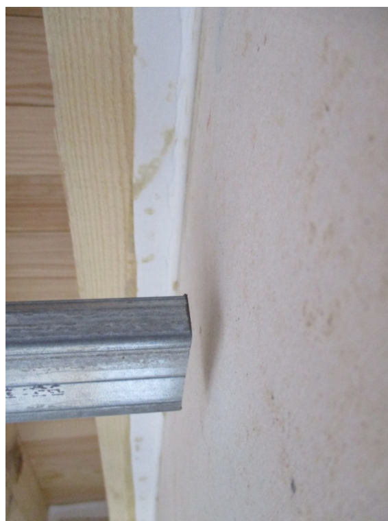
Détail du jeu à l'extrémité d'une fourrure
