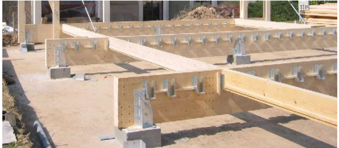
Plancher bas sur vide sanitaire
