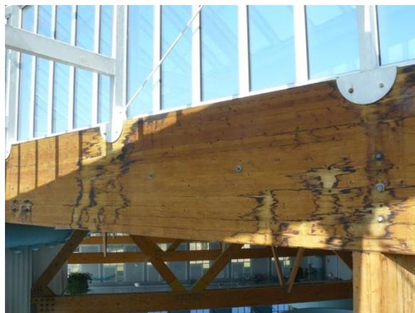
Photo 2 Ouvrage n°2 – ruissellement sur support de verrière
