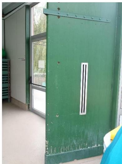
Photo 6 Ouvrage n°4 – Hmax=16% en pied de poteau
