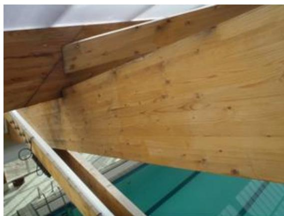
Photo 4 Ouvrage n°3 – Hmax=16% sur panne
