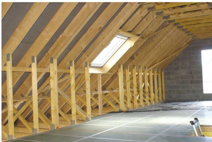
*Figure 2 : Plancher sur entrails porteurs lors de la phase 1*
