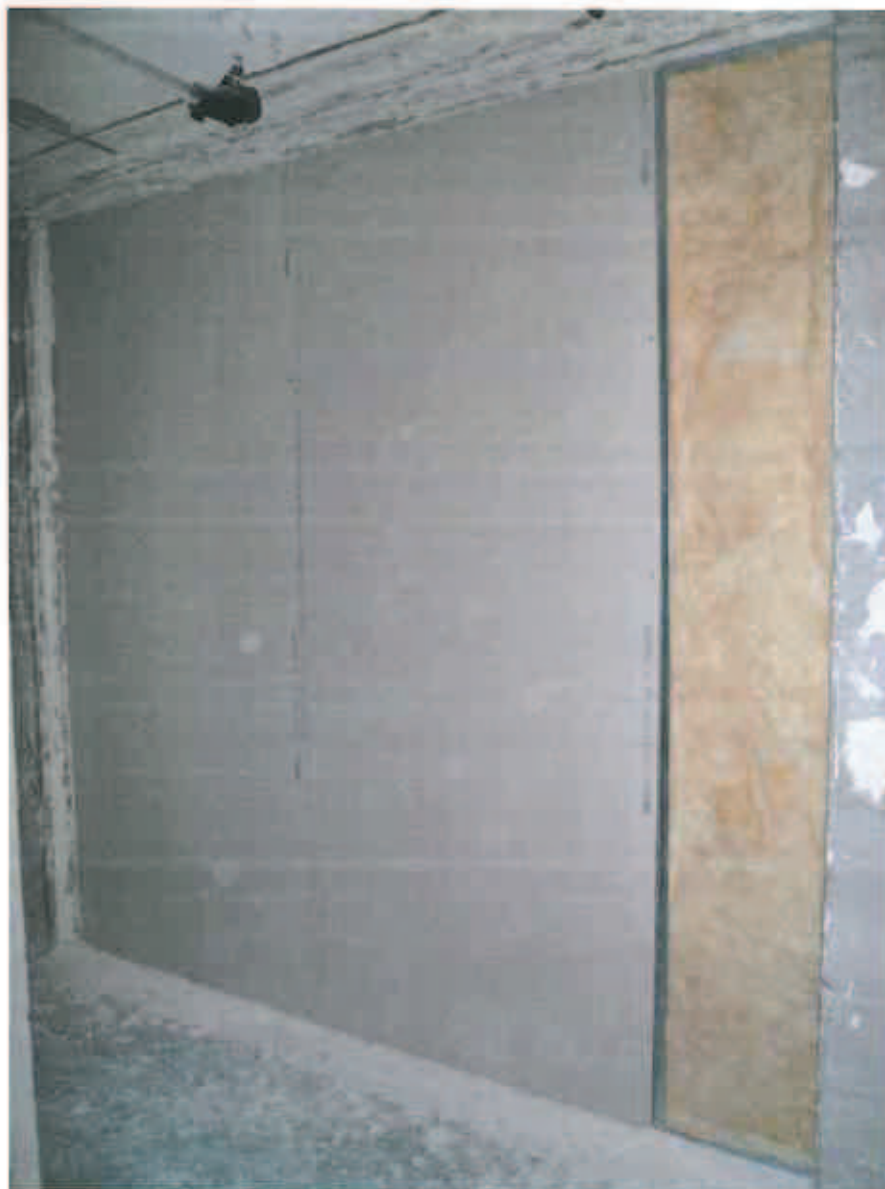
Photo 7 : Espacement entre les montants : 600 mm.
