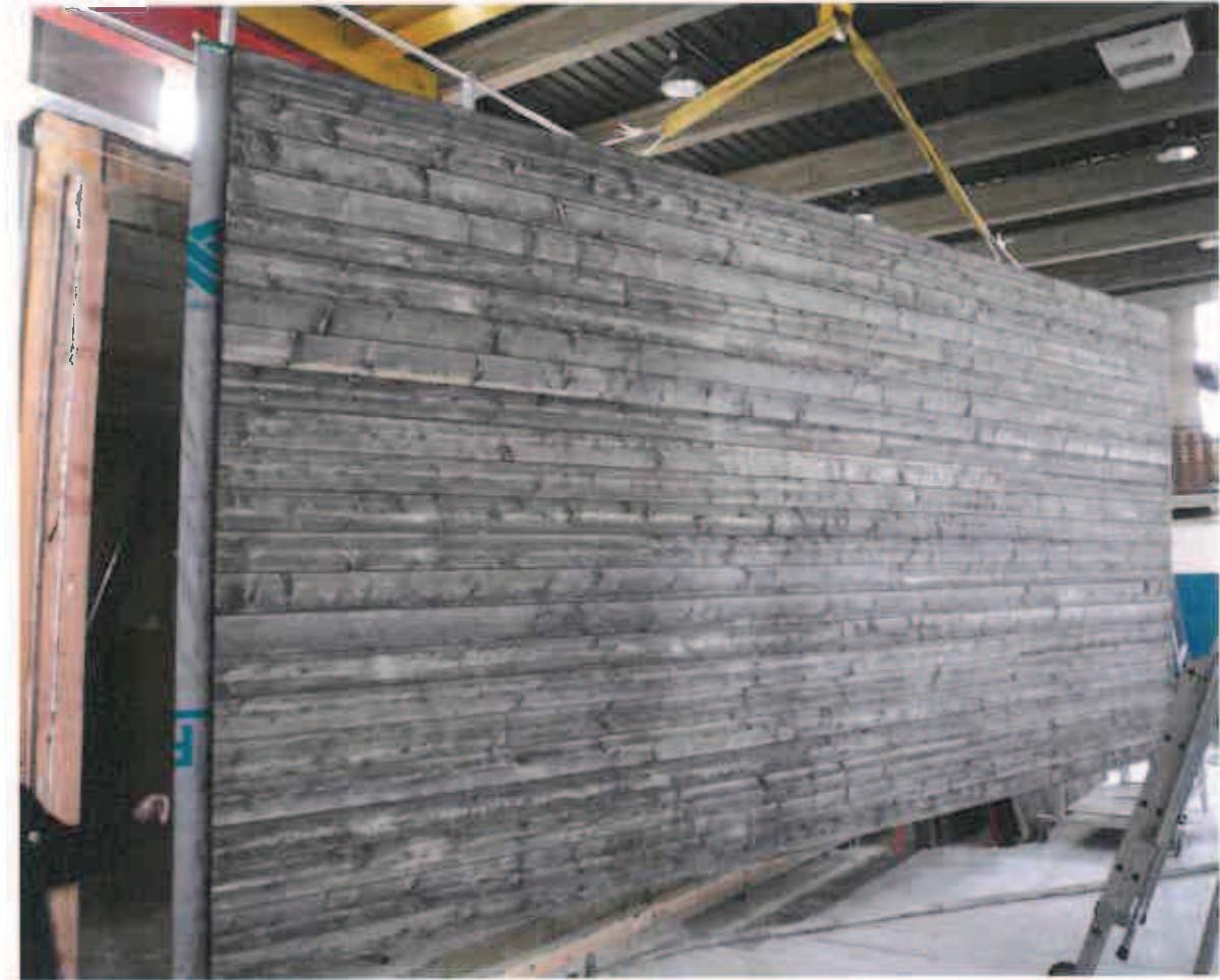
Photos 2 : Montage de la façade d'un seul tenant.
