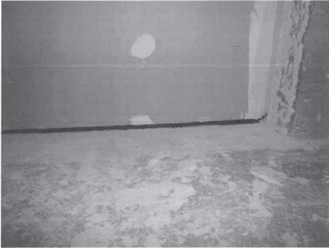
Photo 6 : Joint acrylique en pied de la contre-cloison.
