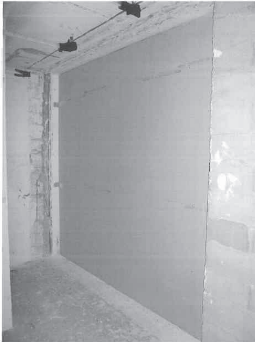
Photo 8 : Espacement entre les montants : 600 mm.
