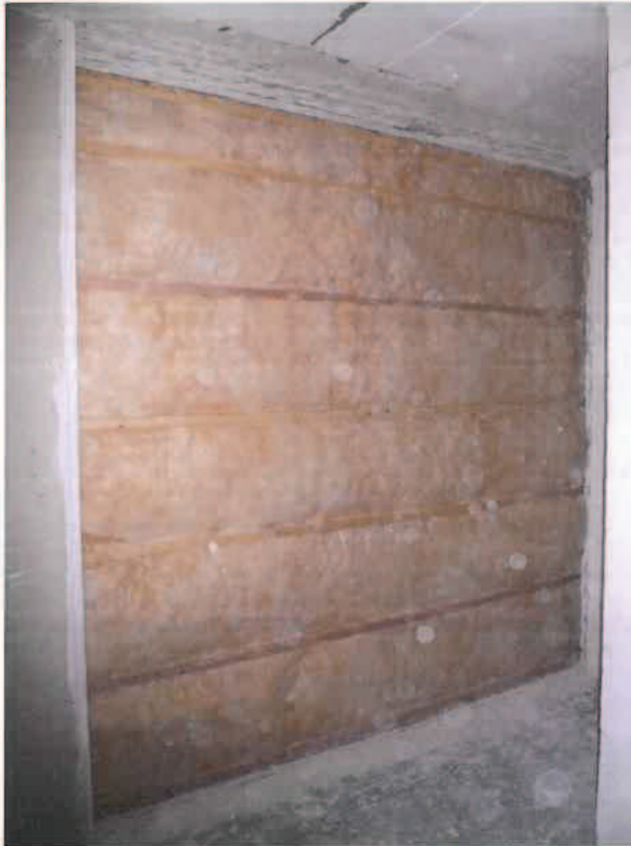
Photo 10 : Contre-cloison une fois la laine minérale et les tasseaux en place.
