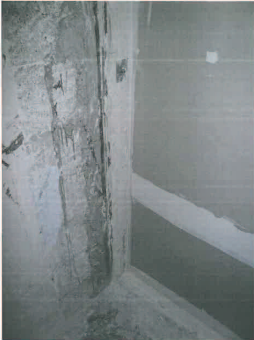
Photo 7 : Joint acrylique sur une portion de contre-cloison.
