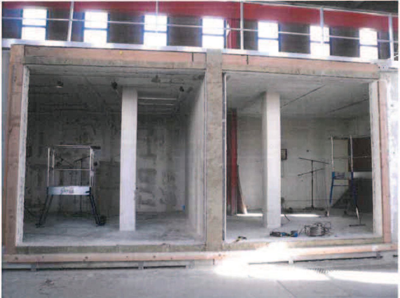
Photo 2 : Laine de roche sur le pourtour du laboratoire
