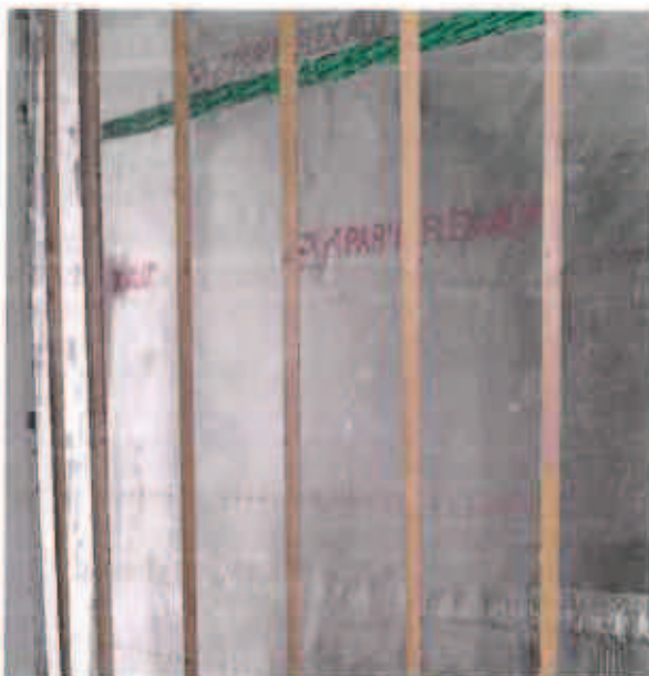
Photo 10 : Montage des tasseaux bois verticalement.
