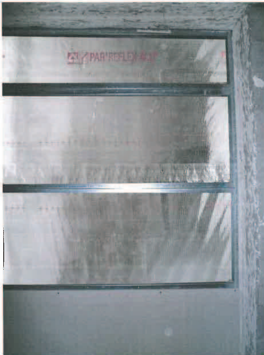
Photo 5 : Espacement entre les montants : 600 mm.
