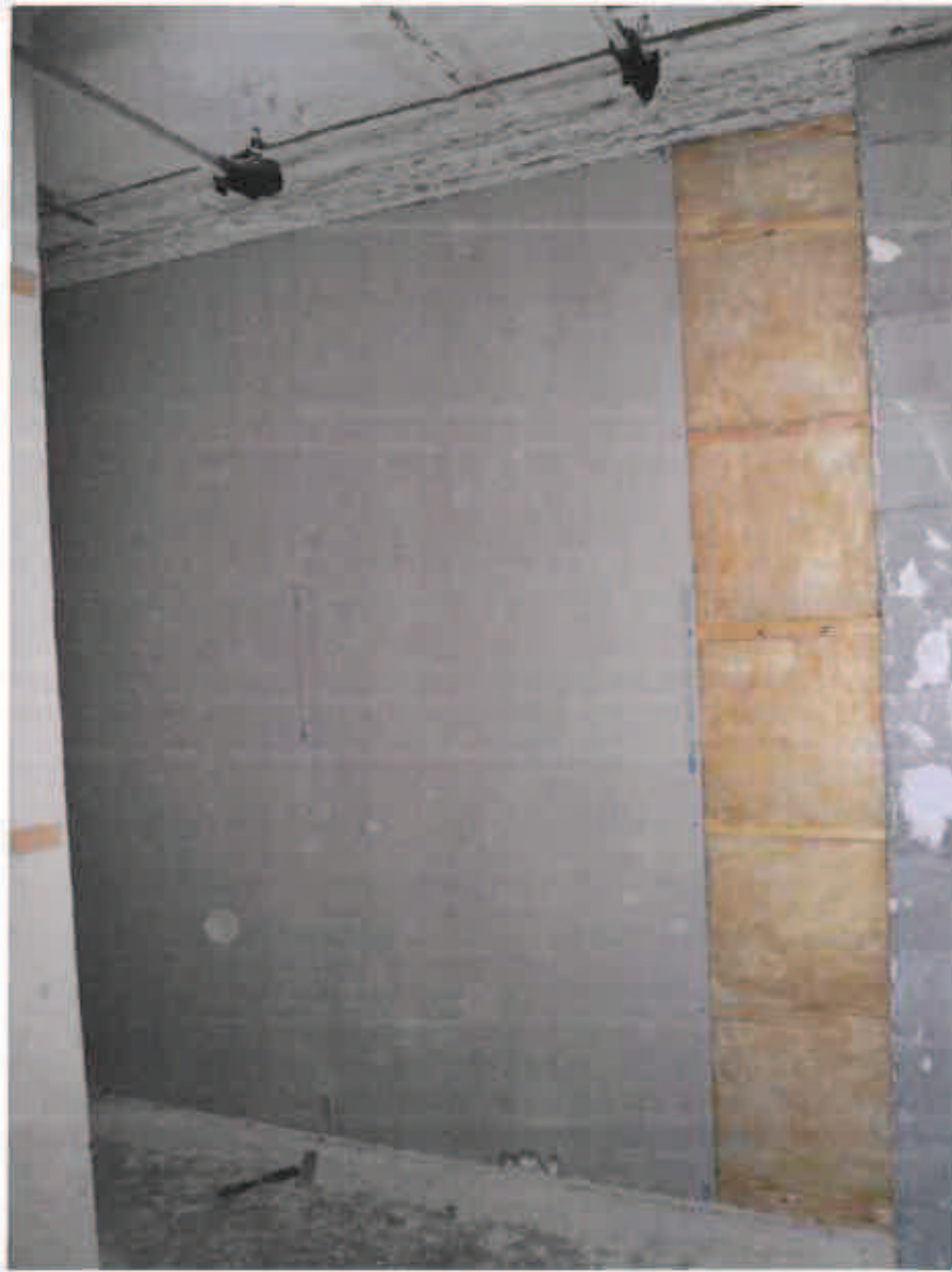
Photo 14 : Pose des plaques de plâtre BA18.
