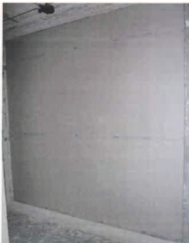
Photo 11 : Pose des deux couches de plaque de plâtre BA13.
