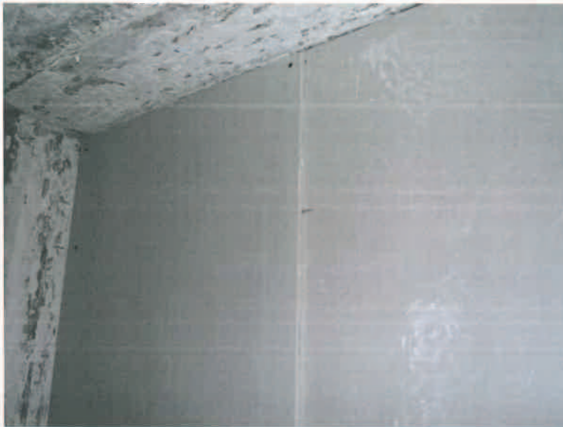
Photo 11 : Pose des deux couches de plaque de plâtre BA13.
