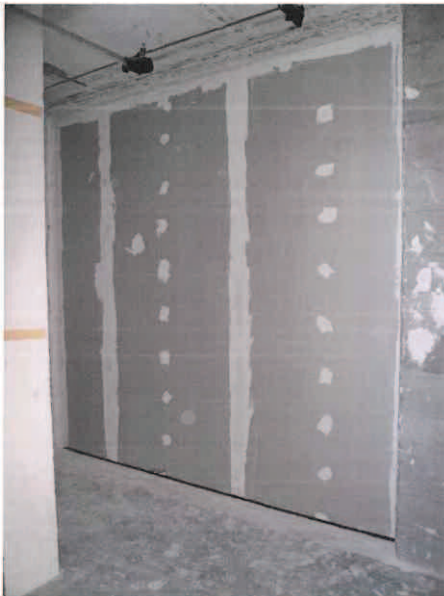
Photo 8 : Enduit sur la contre-cloison du local d'émission.
