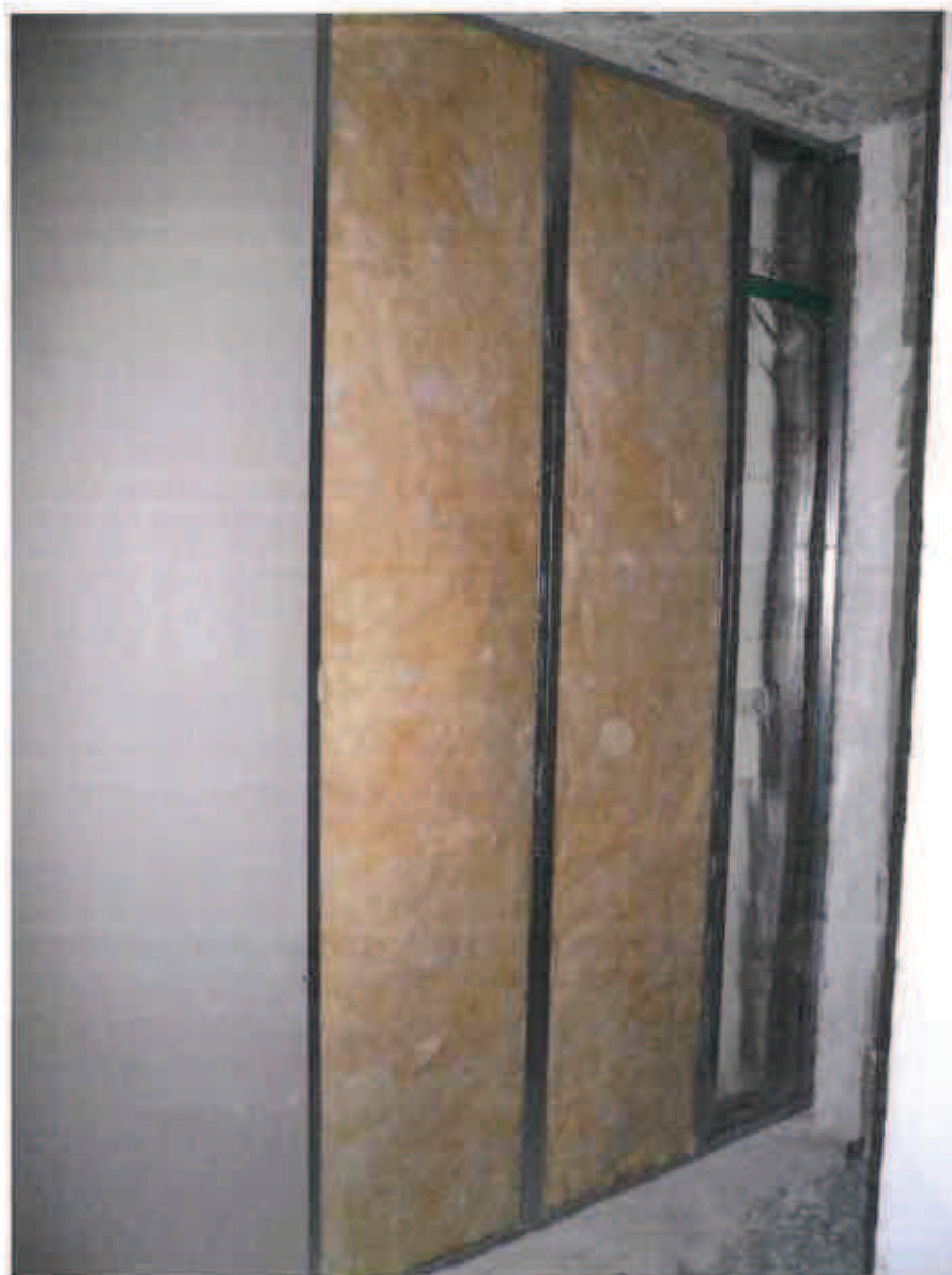
Photo 4 : Espacement entre les montants : 600 mm.
