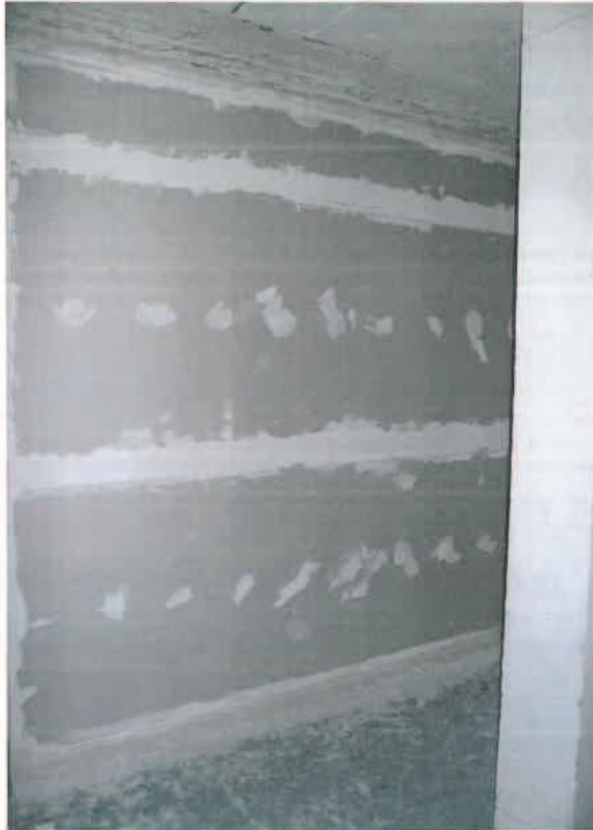
Photo 9 : Enduit sur la contre-cloison du local d'émission.
