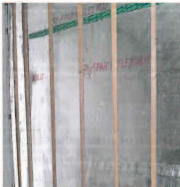
Photo 12 : Montage des tasseaux bois verticalement.
