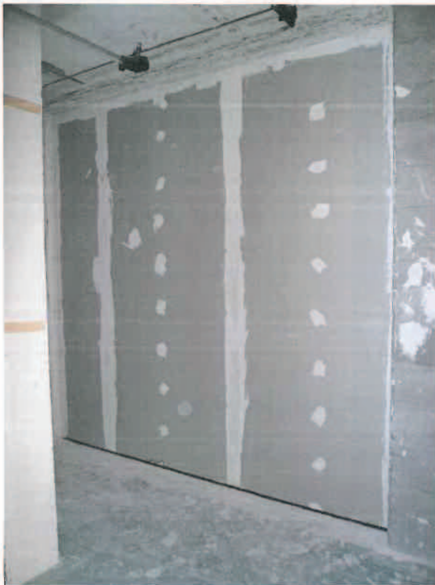
Photo 5 : Enduit sur la contre-cloison du local d'émission.
