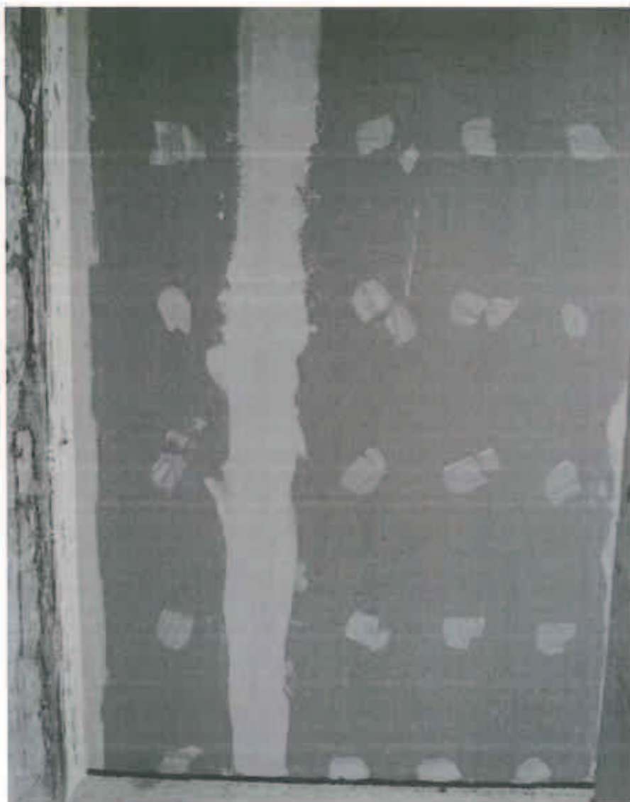
Photo 15 : Enduit sur bande et joint acrylique en pied de la contre-cloison.
