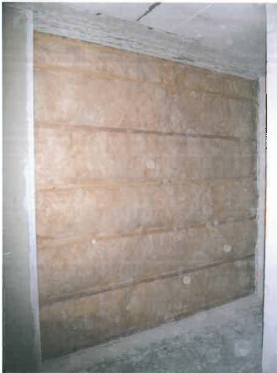
Photo 13 : Contre-cloison une fois la laine minérale et les tasseaux en place.
