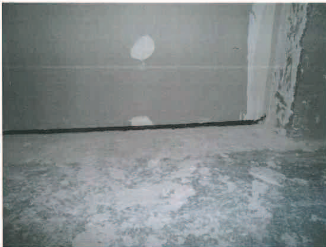
Photo 9 : Joint acrylique en pied de la contre-cloison.
