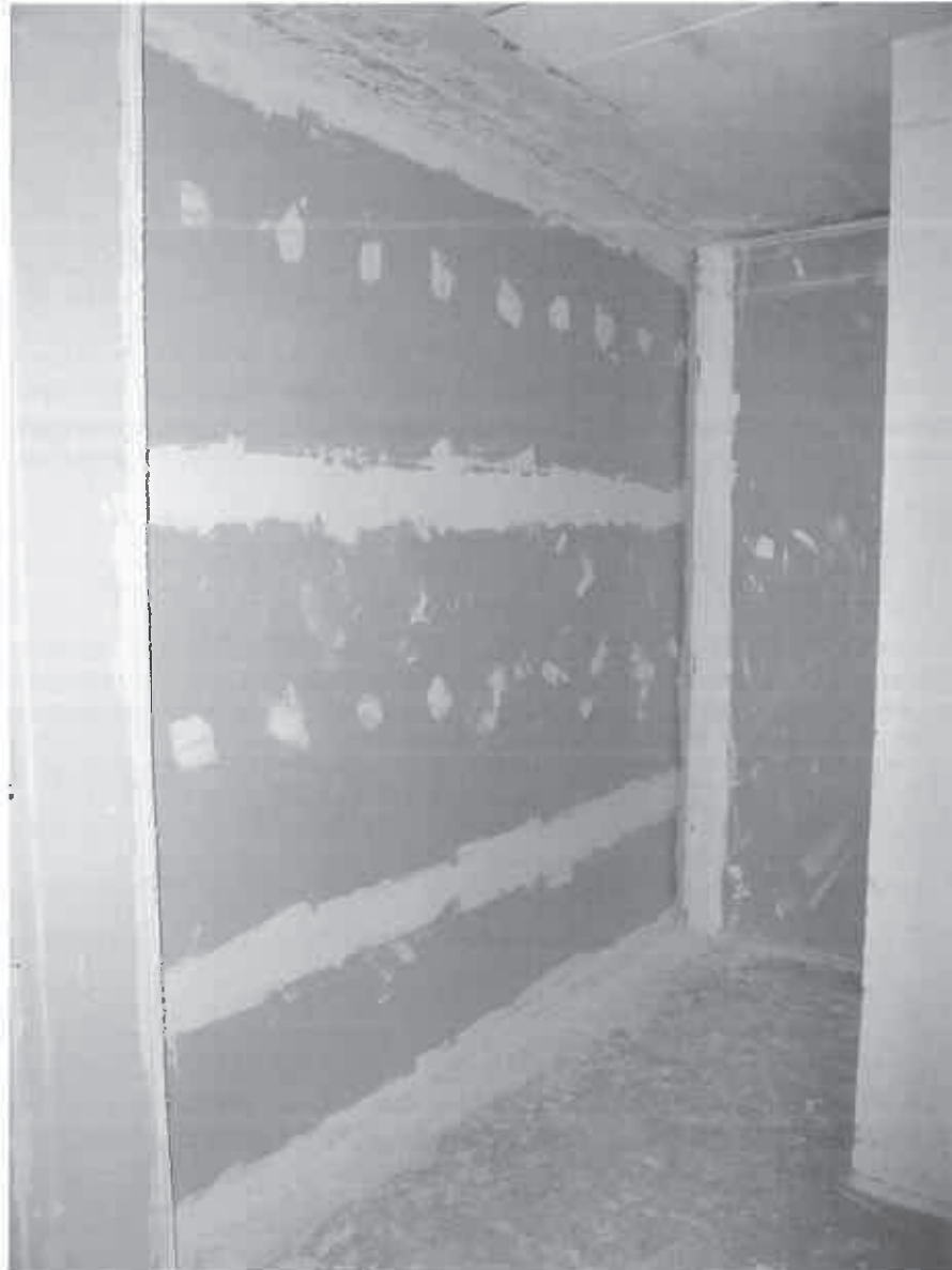
Photo 6 : Enduit sur la contre-cloison du local d'émission.
