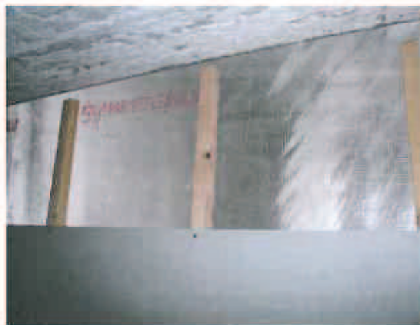
Photo 13 : Pose des plaques de plâtre BA18.
