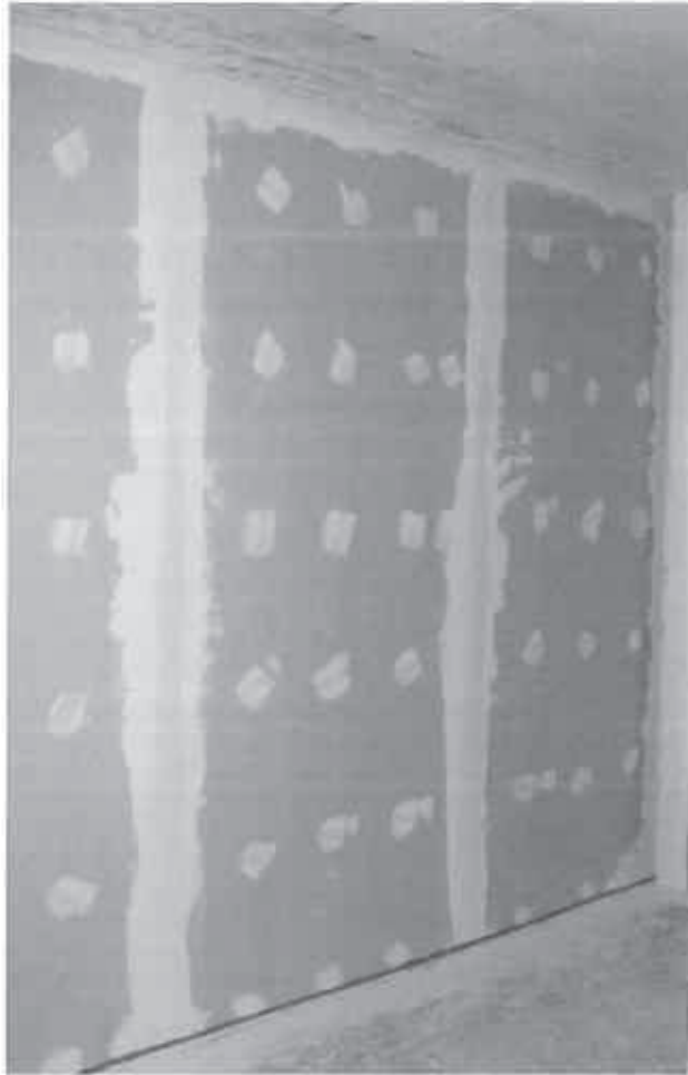
Photo 12 : Enduit sur bande et joint acrylique en pied de la contre-cloison.
