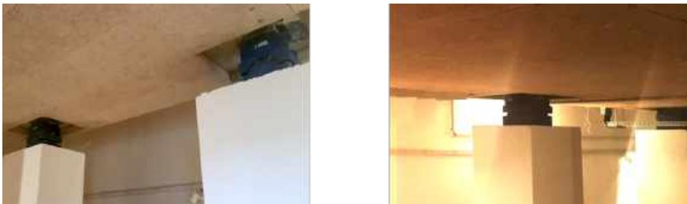
FIGURE 5.2 – Exemple des supports élastiques sur lesquels reposent les chambres du laboratoire acoustique.
