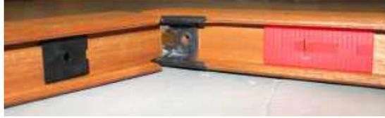
FIGURE 2.3 – Liaison entre le battant et la traverse de l'ouvrant.
