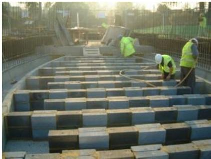
Figure 54 : Labyrinthe thermique en cours de construction © Atelier Ten
