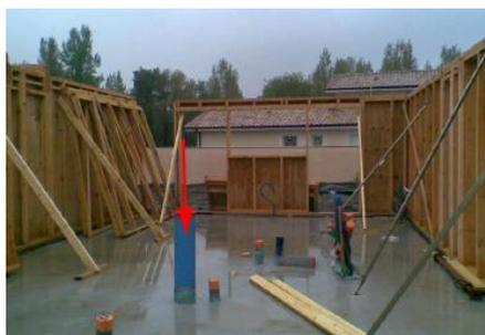
Figure 51 : Arrivée d'une conduite de puits canadien coulée dans la dalle béton du RDC; Maison en Pin Maritime [50]
