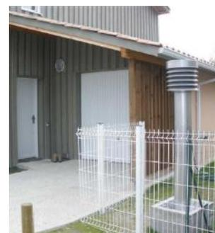
Figure 52 : Entrée d'air d'un puits climatique ; Maison en Pin Maritime [50]
