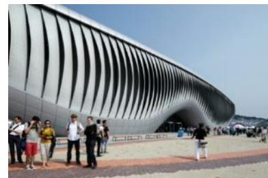
Figure 97 : Pavillon One Ocean avec les lamelles de façade ouvertes ©Kim Yong-kwan
