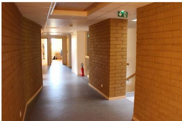
Figure 123 : Intérieur du bâtiment en briques de terre crue © Yves Charmont pour Enertech
