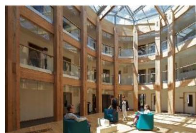
Figure 39 : Atrium équipé d'un système de verrière qui s'ouvre automatiquement © Philippe Ruault
