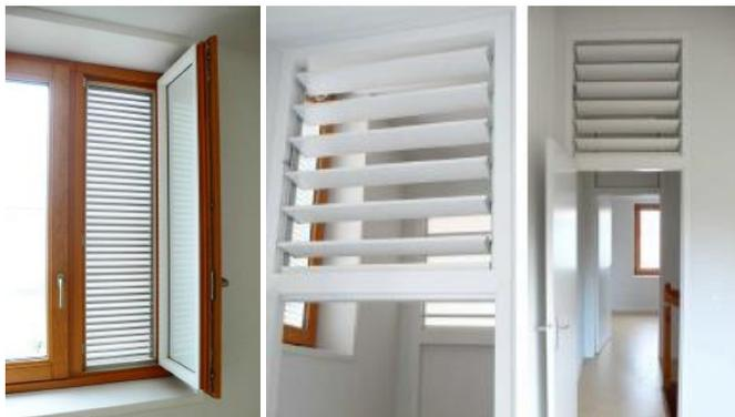
Figure 134 : Photos des volets de ventilation naturelle
