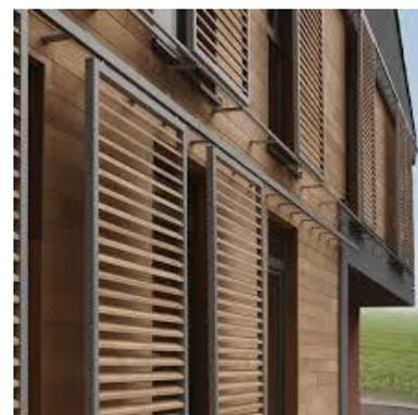
Figure 86 : Brise-soleils verticaux à lames horizontales coulissantes DUCOSLIDE LUXFRAME ©Duco
