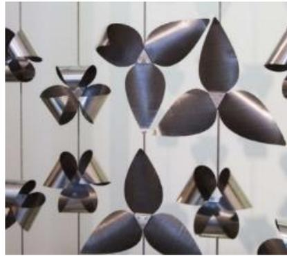
Figure 94 : Modules de façade Pho'liage en métal s'inspirant du système d'ouverture des plantes et matériaux biologiques réactifs © ArtBuild
