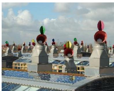
Figure 37 : Capteurs à vent du bâtiment de logements collectifs BedZED, Tom Chance [CC BY-SA 2.0](https://creativecommons.org/licenses/by-sa/2.0/)
