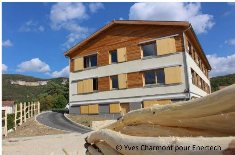
Situé à Pont de Barret (26), le bâtiment Low Cal d'une surface de 730 m<sup>2</sup> abrite les bureaux d'Enertech (bureau d'études fluides). Il possède deux niveaux plus un demi-niveau en rez-de-jardin. Il est composé de matériaux naturels tels que le bois, la paille et la terre crue.
