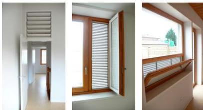
Figure 34 : Grilles de ventilation et de transfert d'air d'un logement basse consommation en Pin maritime, Taillan Médoc ©Christian Maintrot
