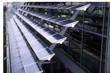
Figure 89 : Brise-soleil avec lames en verre et cellules photovoltaïques © Wikimedia Commons
