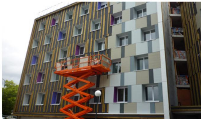
La préfabrication des façades bois suppose un allotissement particulier, qui peut associer la structure à l'isolation, l'étanchéité à l'air, les menuiseries, le bardage. Le détail de ces allotissements est précisé dans le catalogue construction bois.
