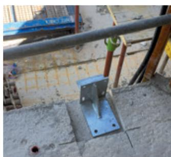
Réservation réalisée après coulage dans des conditions de sécurité délicates
