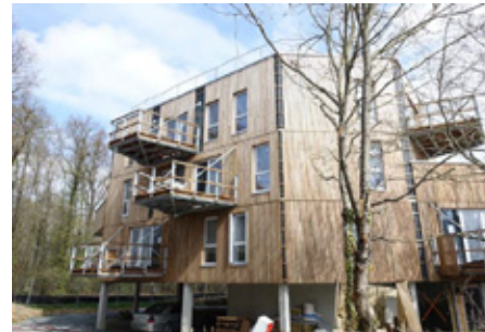
Le décalage des balcons évite les nuisances entre niveaux.
