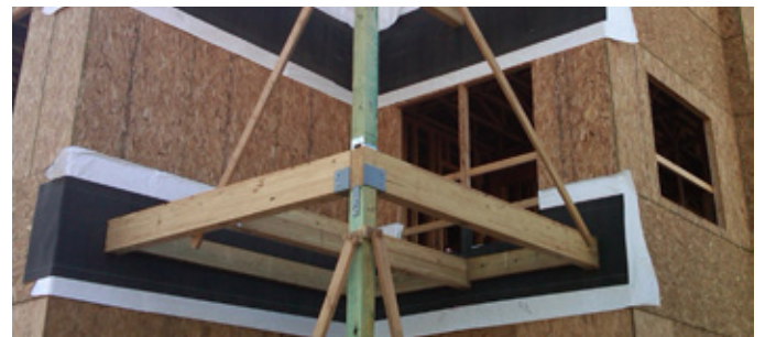
Pour garantir la continuité de l'étanchéité à l'eau de la façade, le film pare pluie est continu derrière la structure porteuse.
