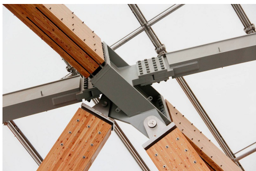
Fig. 1.2 Assemblage de la structure des verrières de la Fondation Louis Vuitton (© Bureau Greisch, www.greisch.com ).
