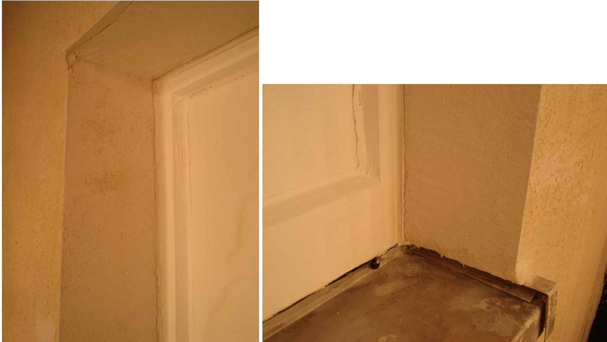
Figure 30 Mise en œuvre de l'enduit sur les maquettes
