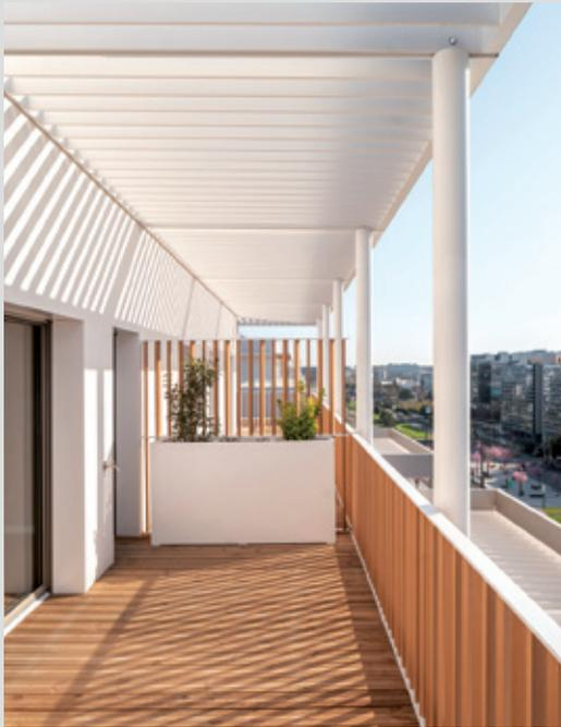
Les logements bénéficient de larges balcons, réalisés avec les chutes de CLT.
