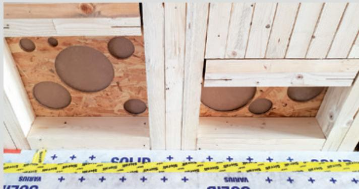
Trémie pour le passage des gaines, avec des réservations réalisées dans l'OSB du plancher.
