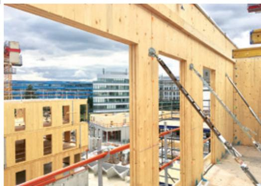
Vue sur le mur en CLT au niveau R+5 ; la sablière en haut du mur accueillera le panneau horizontal CLT qui formera la terrasse avec pente, étanchéité et platelage bois sur plots.
