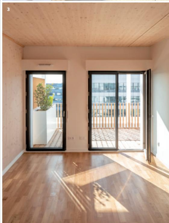
1\_ Les panneaux utilisés pour les balcons sont les chutes de CLT, issues de la découpe des fenêtres.
