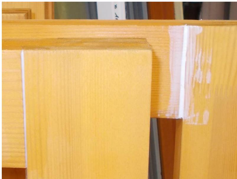
**Figure 5 : Protection spécifique Kodrin avant séchage**
