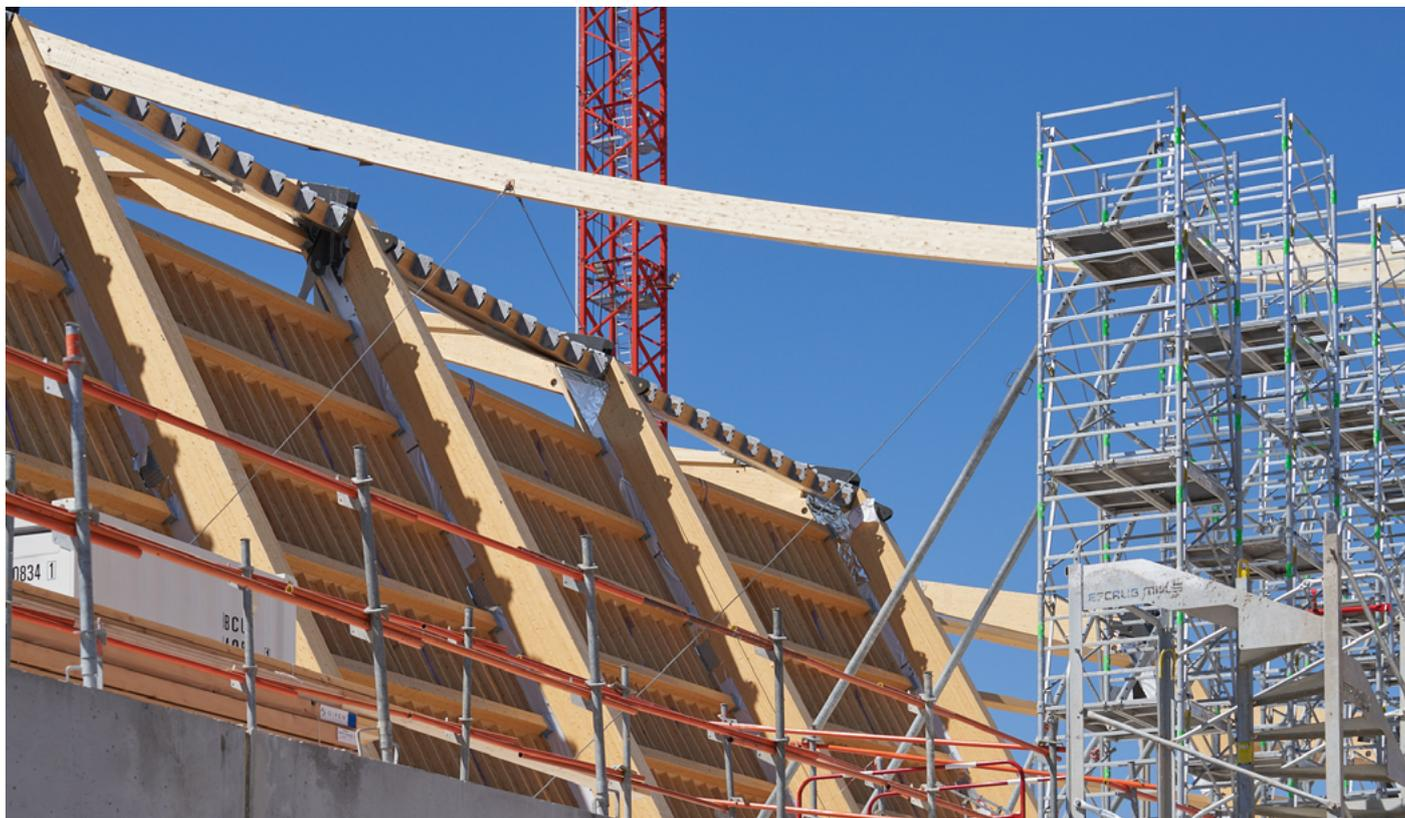
**296 poutres** effilées sont fabriquées en 3 morceaux de près de 30m à l'atelier, et seront assemblées sur le site du chantier pour former la toiture du Centre Aquatique Olympique, en forme de voûte concave.
