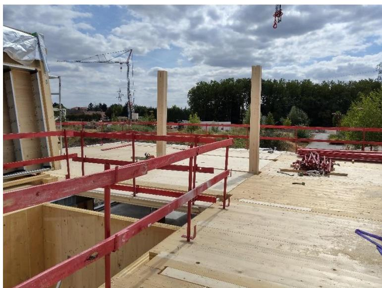
Figure 1 : Garde-corps installés sur un niveau
