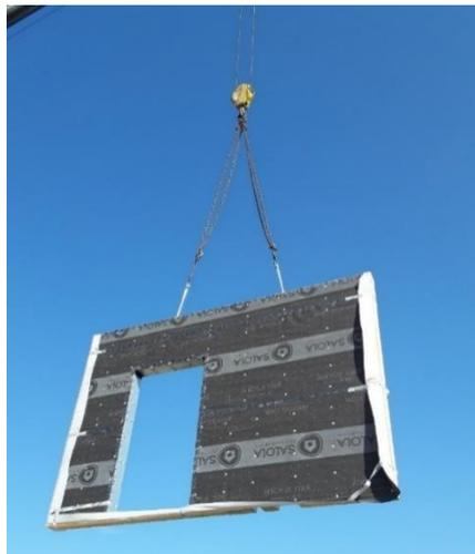
Figure 9 : Levage d'un mur
