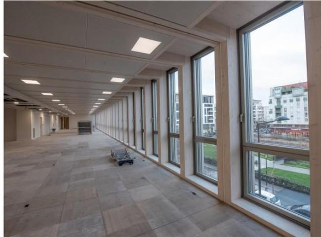
Figure 10 : Système poteaux-poutres en bois lamellé-collé (bâtiment PULSE, Saint-Denis)
