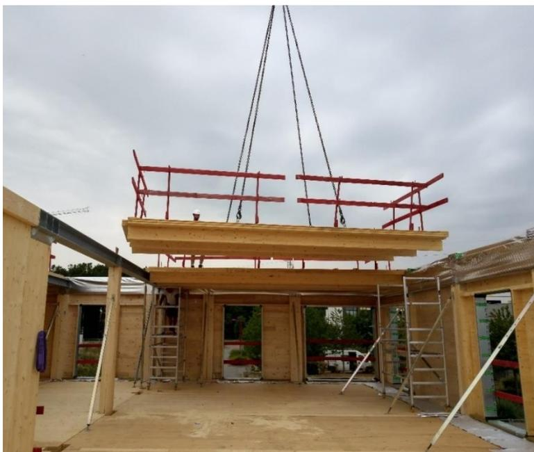
Figure 7 : Manutention d'un panneau de CLT par une grue
