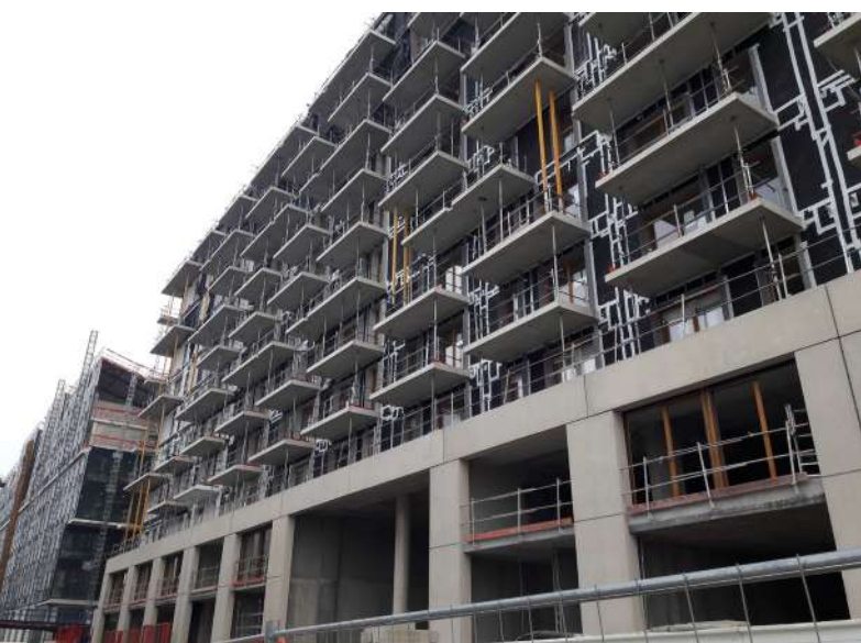
La plupart des bâtiments des lots A et B d'Universeine ont des façades à ossature bois (FOB) recouvertes de pare-pluie
