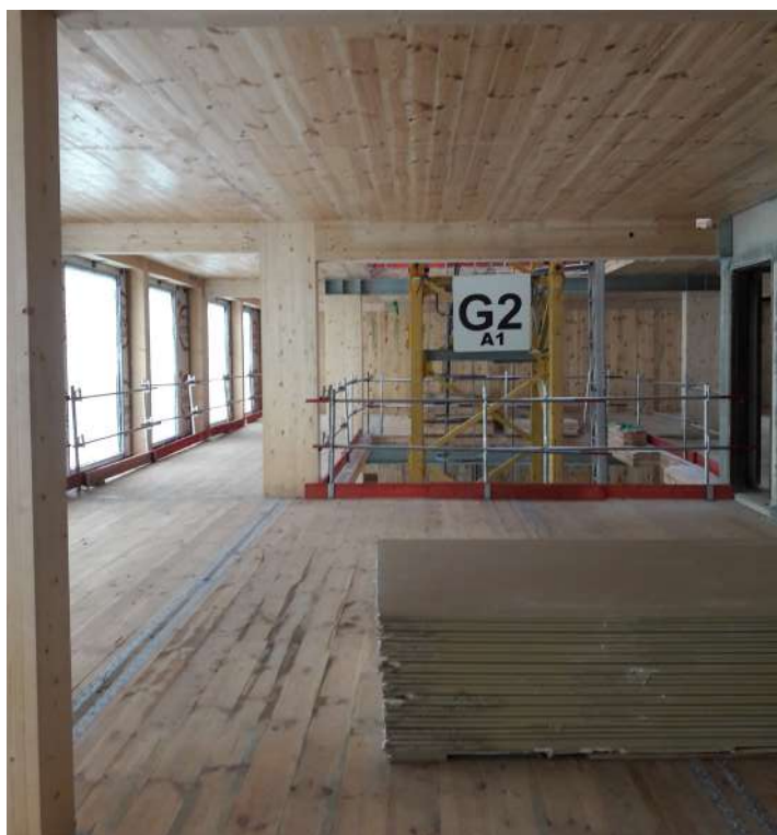
Mixité des matériaux : certaines poutres sont métalliques pour alléger la structure.
