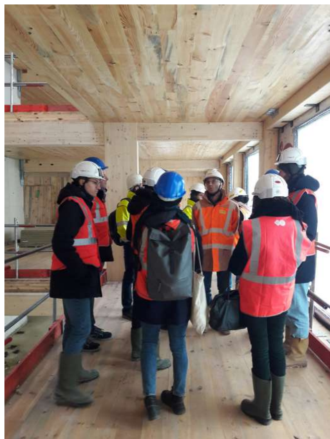
Présentation de l'opération par Steve Montigny de Spie Batignolles Outarex, entreprise générale.
