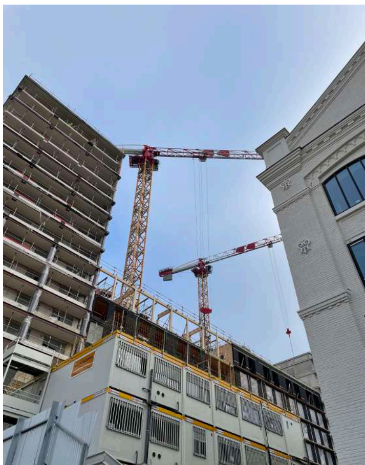
Vue de la tour Signal du lot A1 (en structure béton).
