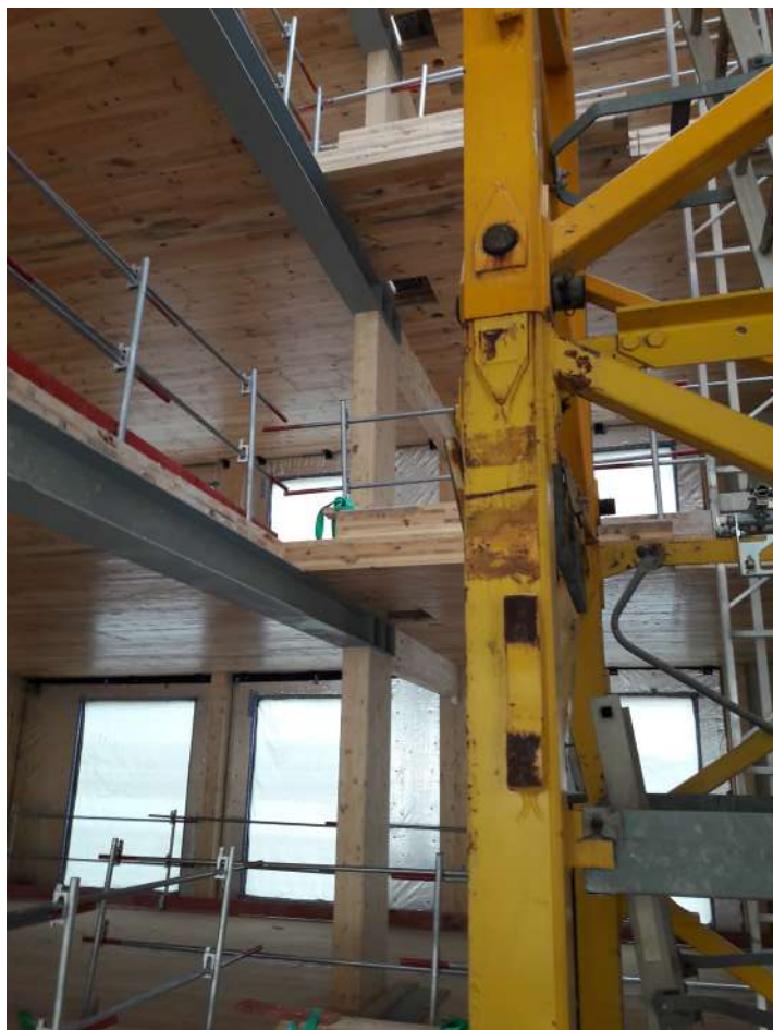
Mixité des matériaux : certaines poutres sont métalliques pour alléger la structure.
