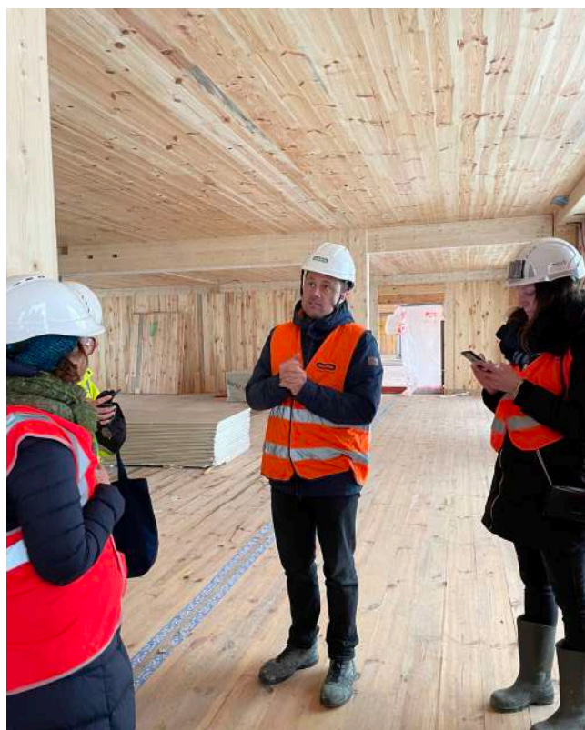
Pierre Mathis présente la partie bois du chantier.
