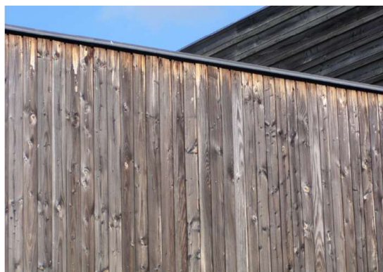
Figure 9 : Influence de détail architecturaux sur le développement de microorganismes et champignons de bleuissement à la surface d'un bardage bois exposé au sud. (Photographie FCBA ©)
