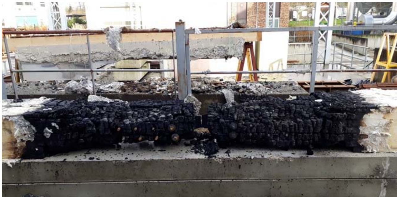
Figure A5.5 : Campagne 1 – Configuration 2 – Assemblage après essai
