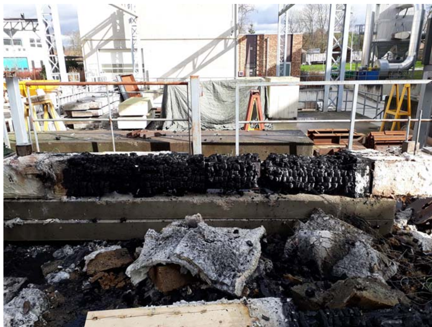
Figure A5.11 : Campagne 2 – Configuration 1 – Assemblage après essai
