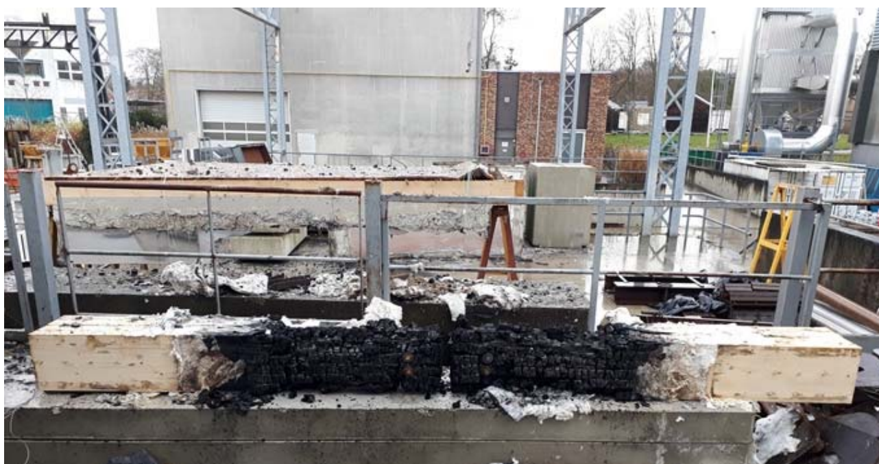
Figure A5.2 : Campagne 1 – Configuration 1 – Assemblage après essai
