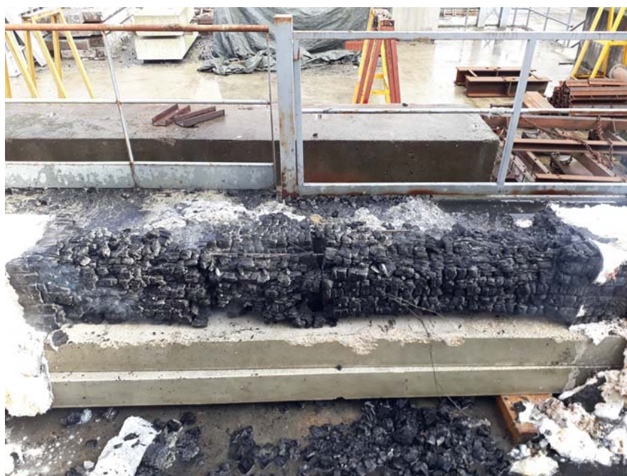
Figure A5.14 : Campagne 2 – Configuration 2 – Assemblage après essai
