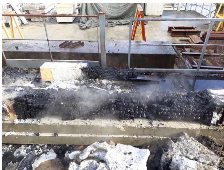
Figure A5.12 : Campagne 2 – Configuration 1 – Assemblage après essai
