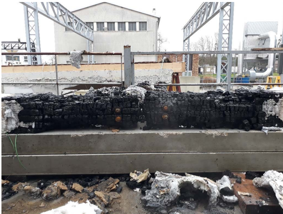
Figure A5.9 : Campagne 1 – Configuration 1' – Assemblage après essai
