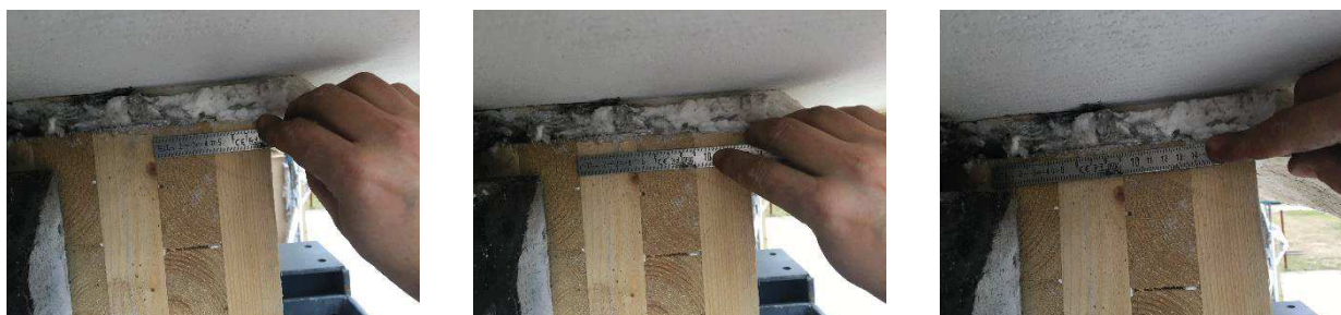
Figure 2-6 : Prises de vue de l'épaisseur des plis de la paroi CLT MUF (Essai 1)
