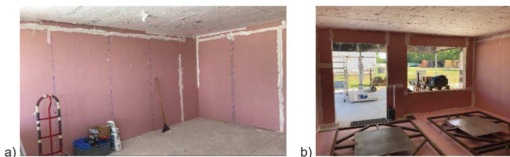
Figure 2-3 : Vue de l'habillage intérieur de la cellule d'essai avec a) des plaques de plâtre cartonnée feu sur les parois et b) des nappes de fibre de verre haute température au plafond
