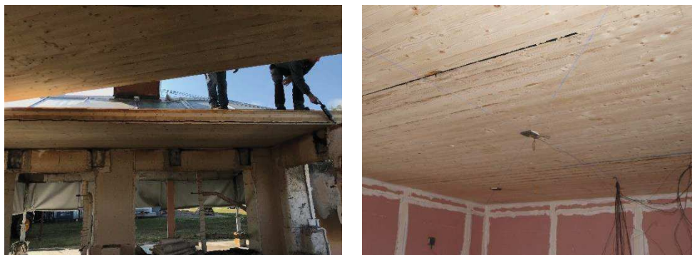
Figure 5-1 : Vue du montage et intérieur du plafond CLT avec colle MUF (Essai 2)
