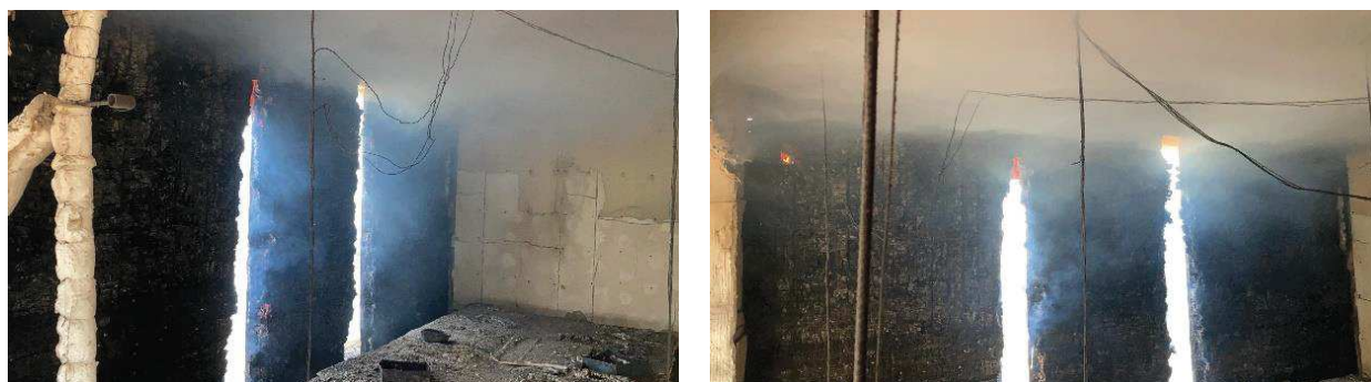
Figure E-37 : Vues intérieures des percements au niveau des feuillures le lendemain de l'essai 1
