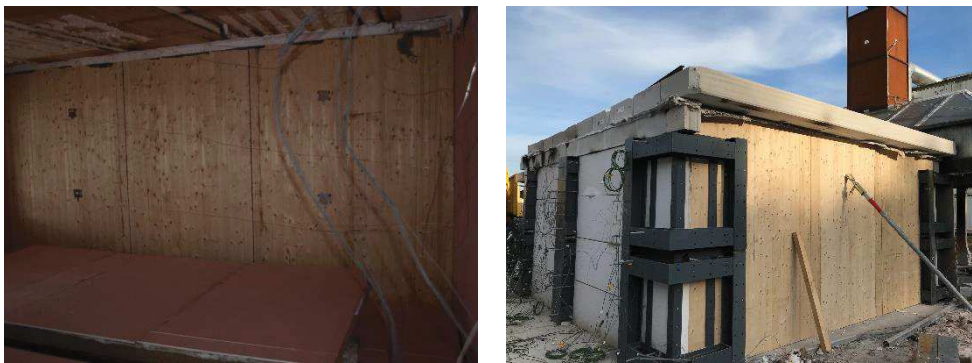
Figure 4-1 : Vue intérieure et extérieure de la paroi CLT avec colle MUF (Essai 1)
