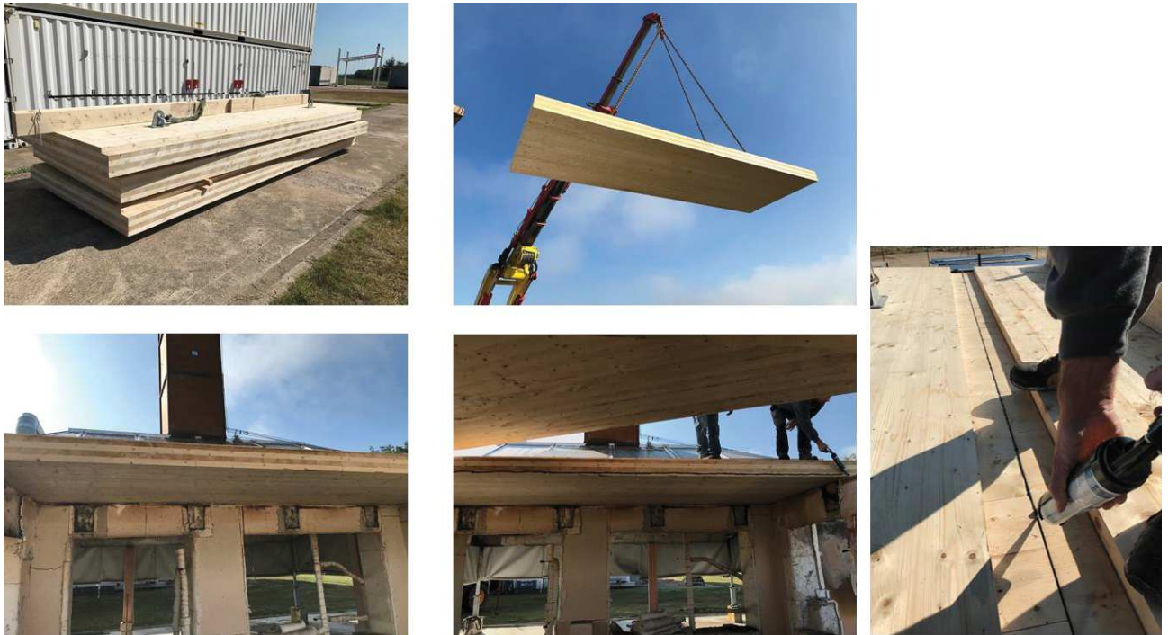
Figure B-27 : Prises de vue pendant la mise en place des panneaux CLT du plafond pour l'essai 2
