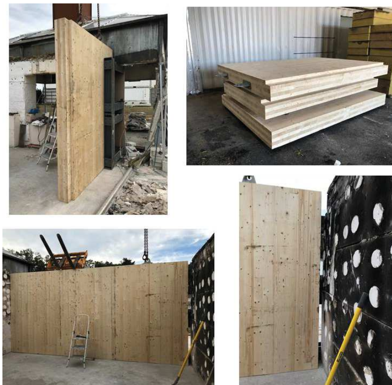
Figure B-26 : Prises de vue pendant la mise en place des panneaux CLT de la paroi pour l'essai 1
