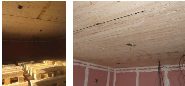
Figure 7-1 : Vue du plafond CLT colle PU (Essai 4)
