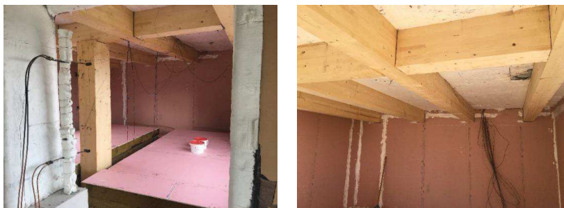
Figure 6-1 : Vue du poteau et des poutres BLC de l'Essai 3
