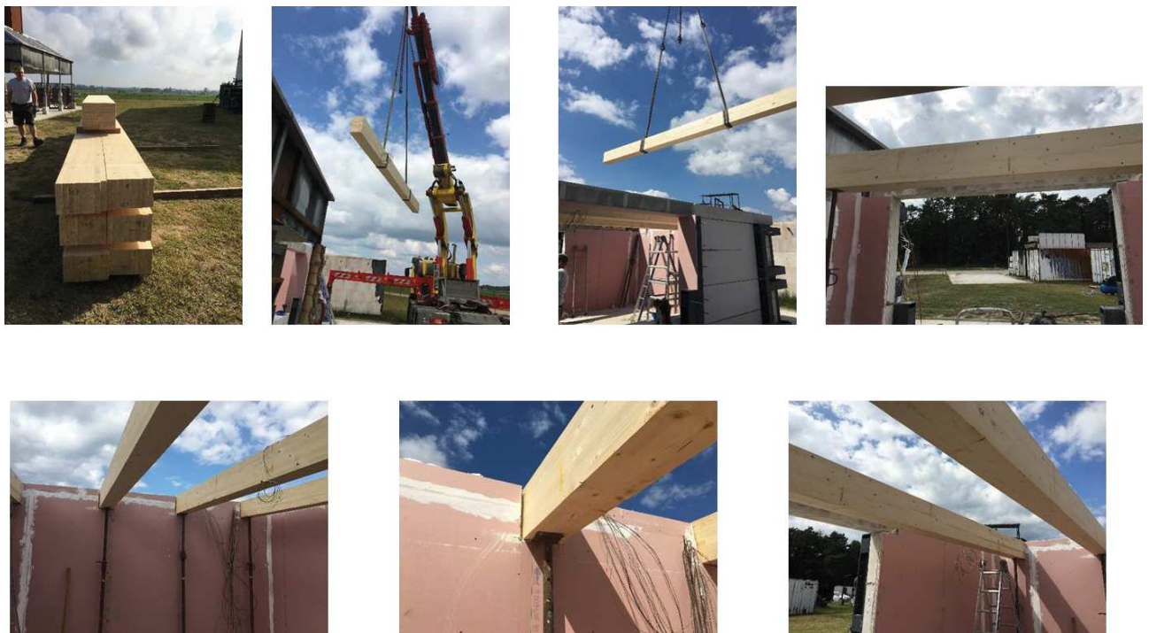
Figure B-28 : Prises de vue pendant la mise en place des poutres LC pour l'essai 3
