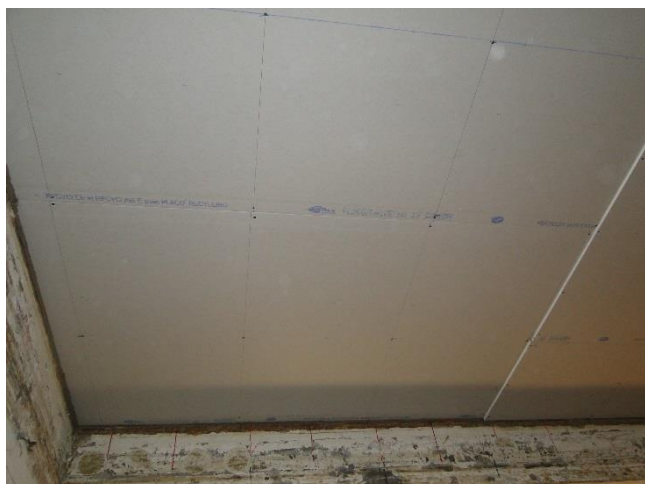
Fixation de la seconde peau en BA13
