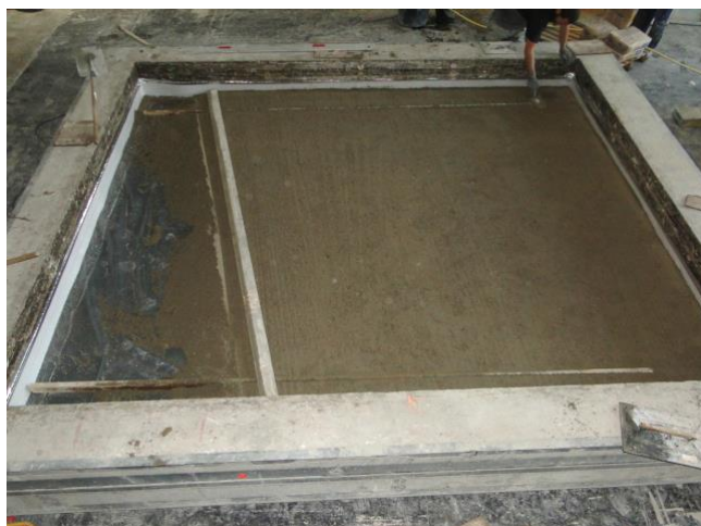
Coulage de la chape flottante
