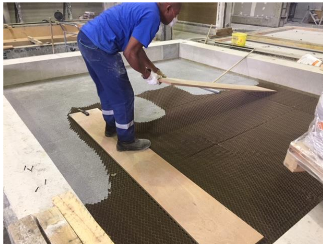
Mise en place du nid d'abeille (Essais 9 à 11)
