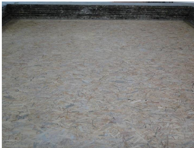
Chape sèche terminée
