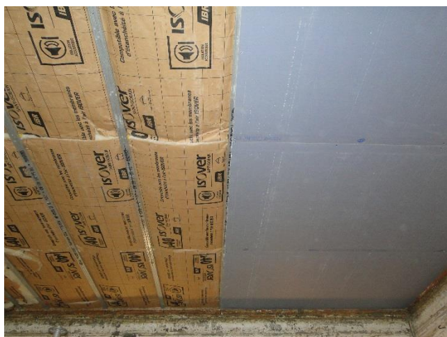
Fixation des plaques de parement
