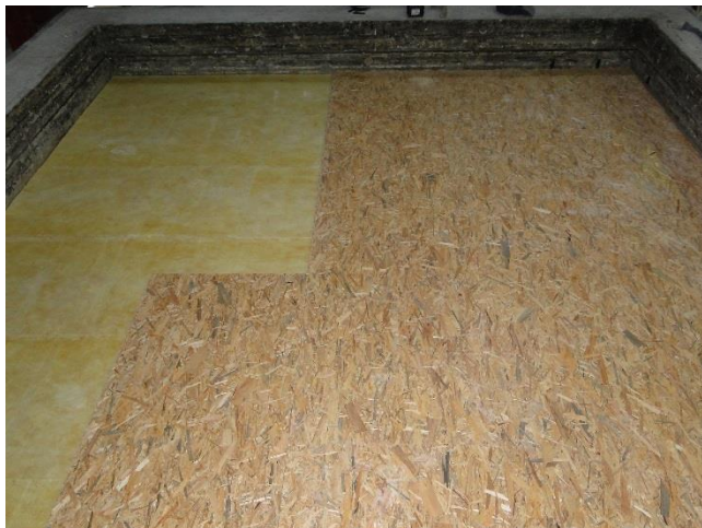
Mise en place des panneaux d'OSB sur la sous-couche
