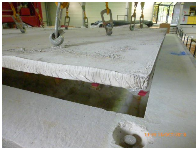
Pose de la préchape en béton armé (Essais 14 à 17)
