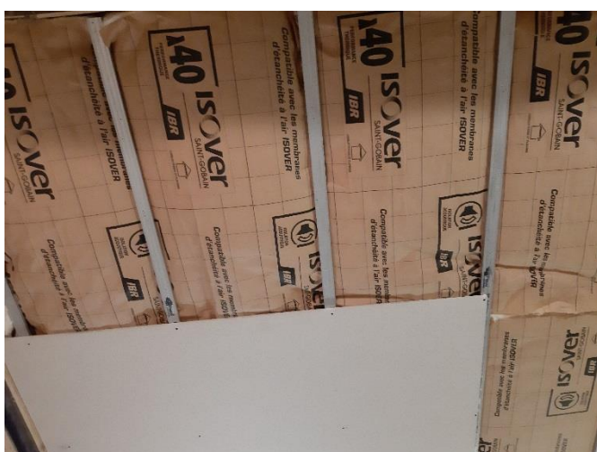
Montage du plafond (Essais 46 et 47)
