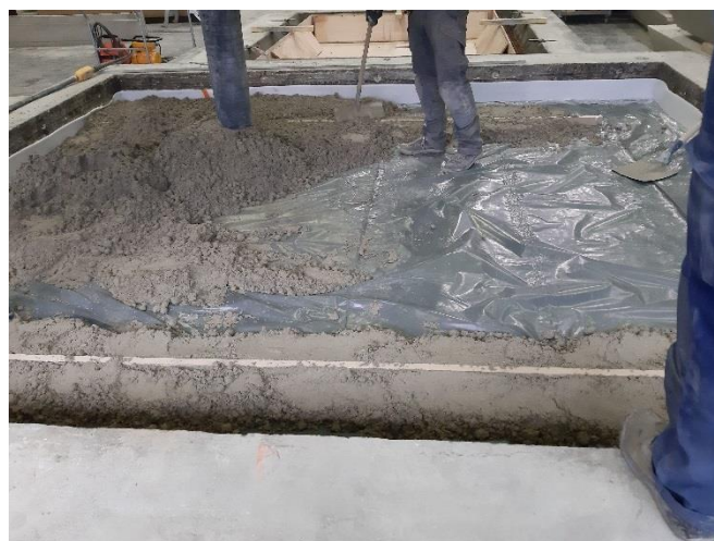
Coulage de la chape (Essais 6 à 8)
