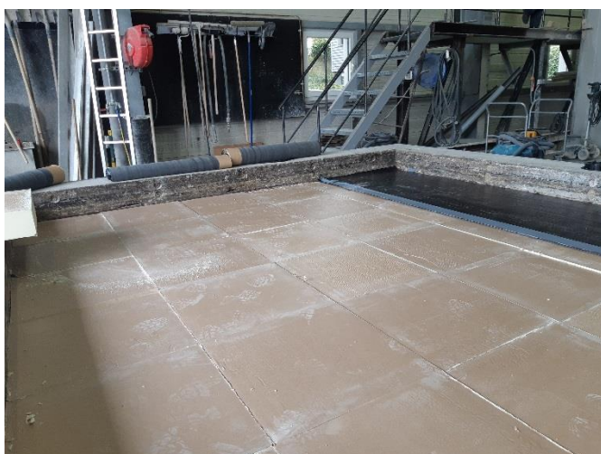
2nd couche de membrane d'étanchéité
