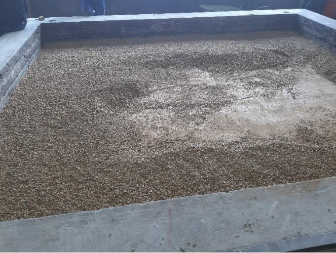
Mise en place du gravier sur le plancher support
