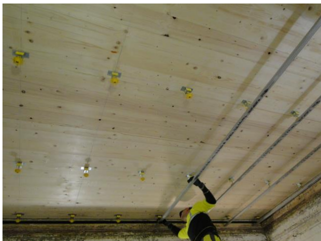
Fixation des fourrures sur les suspentes
