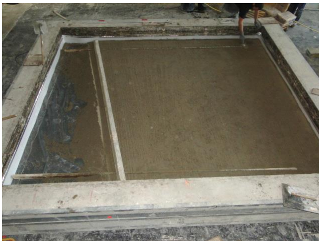
Coulage de la chape flottante
