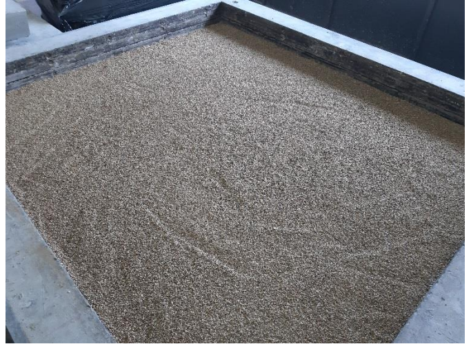
Mise en place du gravier sur le plancher support
