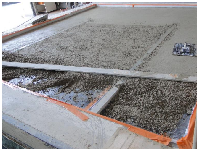
Coulage de la chape (Essais 18 à 39)
