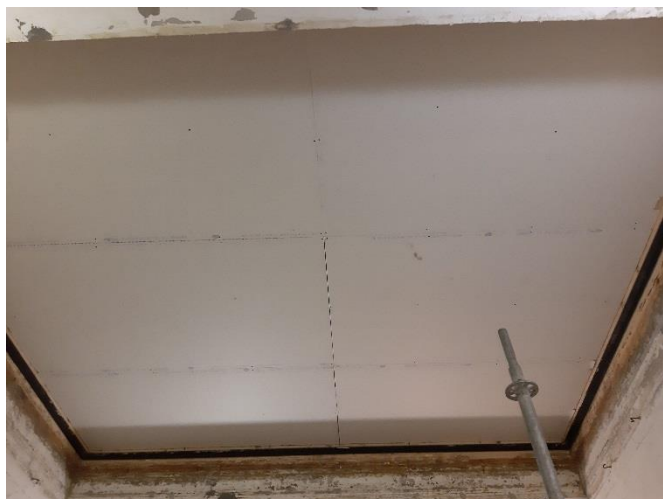
Montage du plafond en sous face
