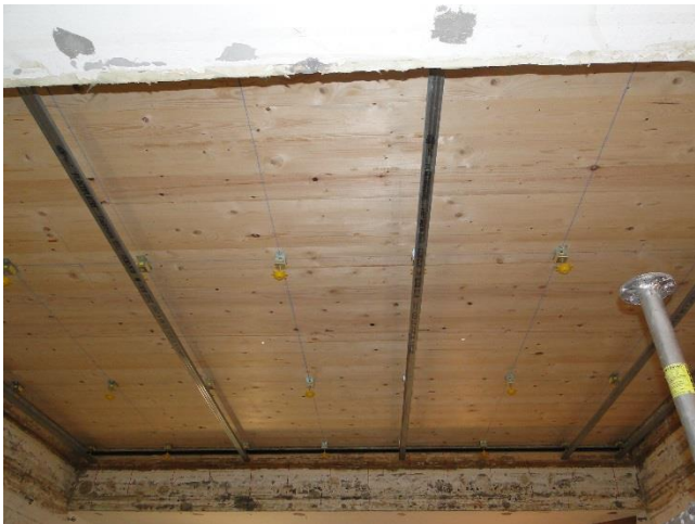
Fixation des fourrures sur les suspentes
