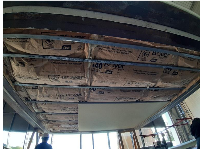
Montage du plafond en sous face (essais 52 à 55)
