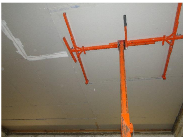
Mise en place de la seconde peau en plaques de plâtre
