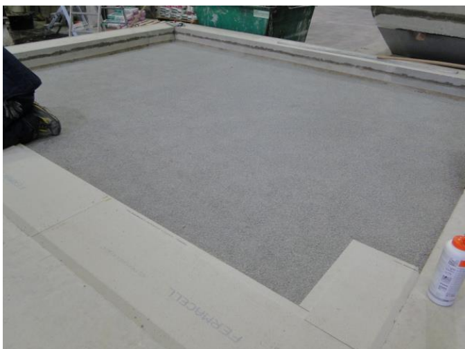
Pose des plaques de de chape sur nid d'abeille
