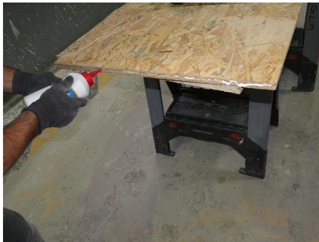
Encollage des rainures des panneaux d'OSB
