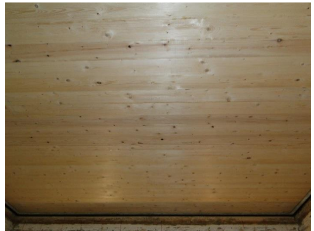
Sous-face du plancher
