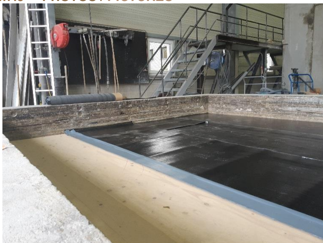
1ère couche de membrane d'étanchéité
