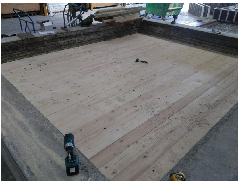
Plancher posé dans le cadre en béton
