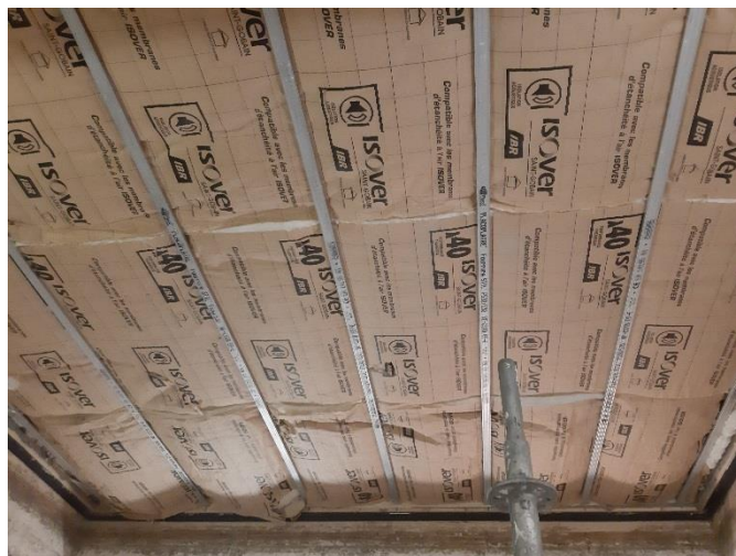
Pose de l'ossature et l'isolant (Essais 23 à 39)
