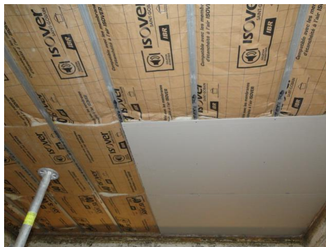
Fixation des plaques de la première peau en plaques de plâtre
