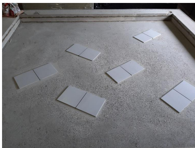
Pose du carrelage (Essais 38 et 39)
