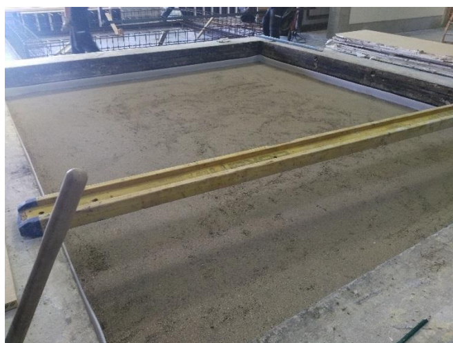
Mise en place de la chape de ravoilage (Essais 3 à 8)
