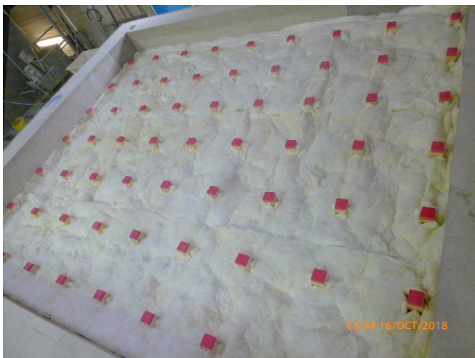
Mise en place de l'isolant (Essais 14 à 17)
