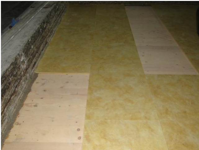
Mise en place des panneaux de sous-couche sur le plancher
