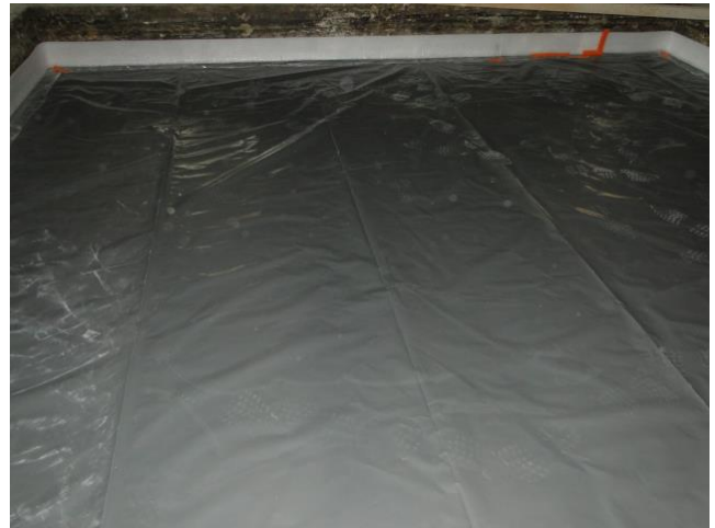
Vue du film plastique recouvrant la sous-couche et de la bande de rive
