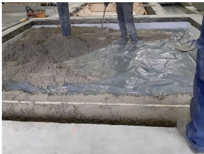
Coulage de la chape (Essais 6 à 8)
