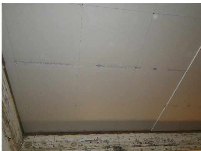
Fixation de la seconde peau en BA13
