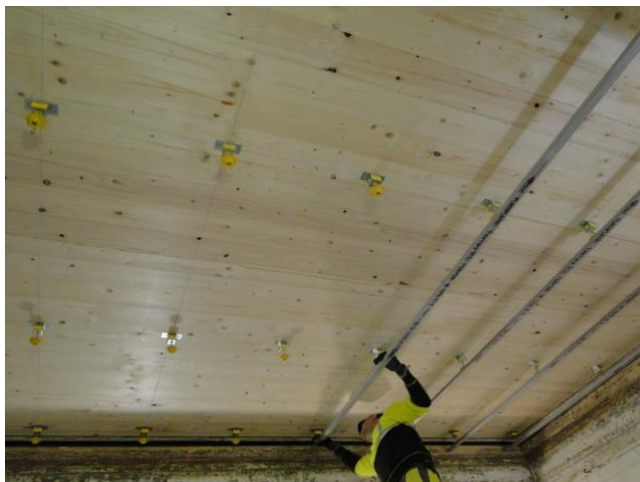
Accrochage des fourrures sur les suspentes
