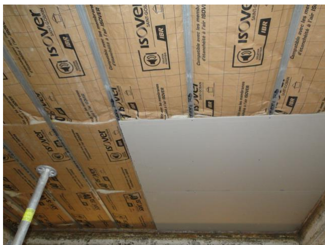
Fixation des plaques de parement
