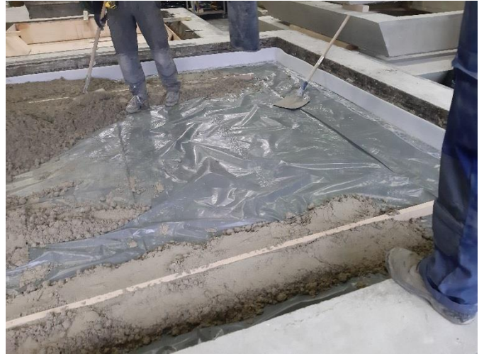
Coulage de la chape
