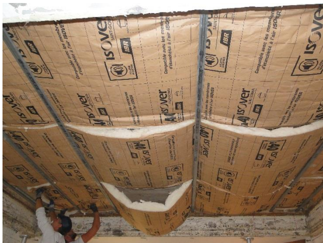
Mise en place de la laine de verre
