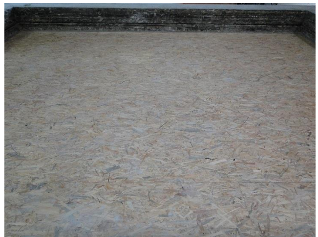
Chape sèche terminée
