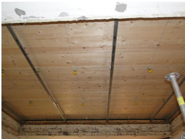
Fixation des fourrures sur les suspentes
