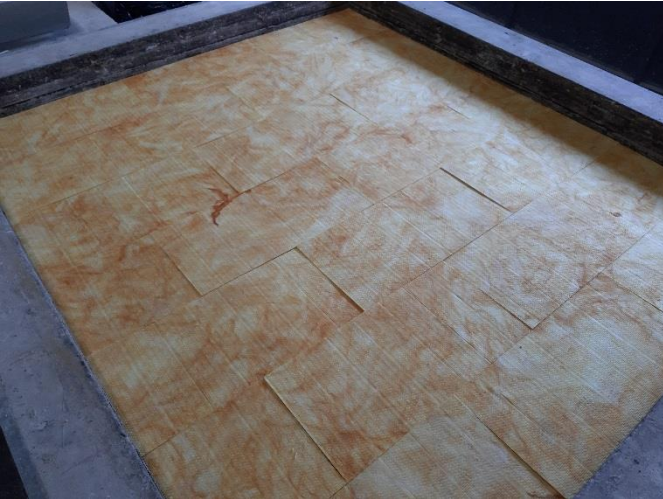
Mise en place de la sous couche
