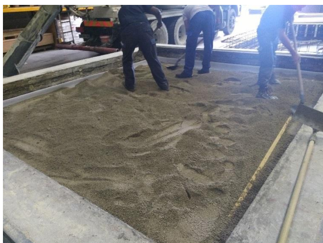
Mise en place de la chape de ravoilage (Essais 3 à 8)
