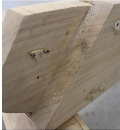
Photo 14 et Photo 15 : Légères traces de moisissures sur les faces de l'assemblage Contrefiche/Arbalétrier
