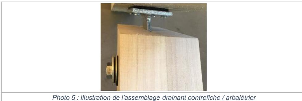
La Photo 5 ci-dessus permet également d'apercevoir la platine métallique de liaison, en âme de la contrefiche avec deux boulons de fixation puis vissée, en partie haute, en appui contre la face de l'arbalétrier avec interposition d'une cale d'étanchéité en EPDM.
