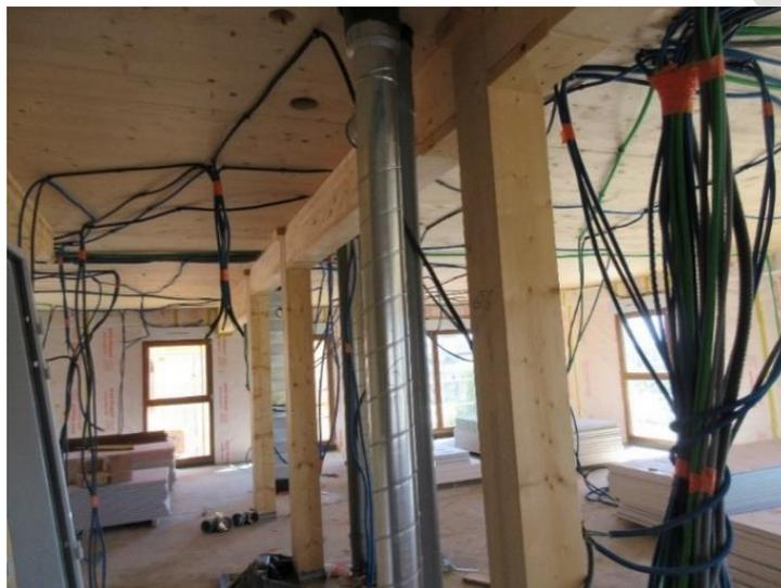
Figure 23 : Système poteau-poutre entre façade et noyau utilisé pour le Plot C (Source : Bois HD)
