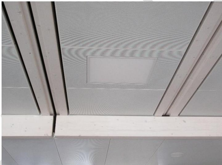
Figure 39 : Vue de l'interruption du deuxième joint de dilatation au
