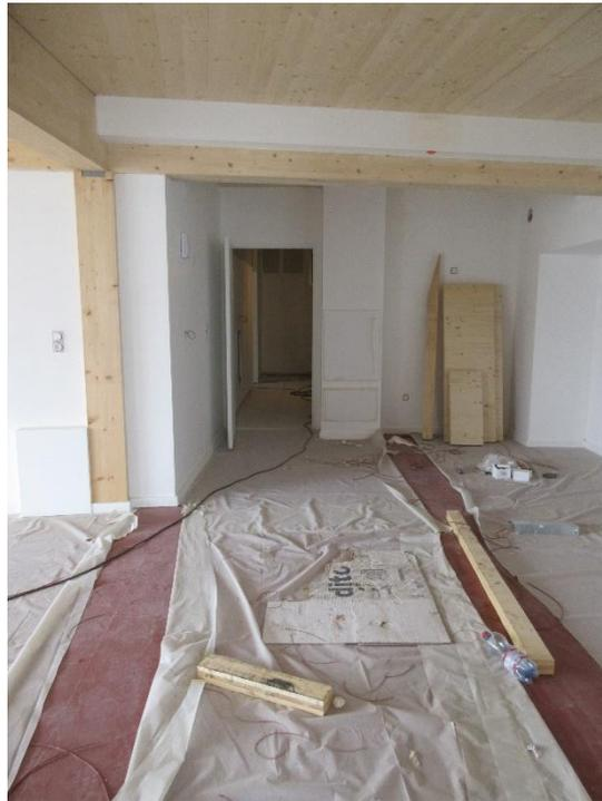
Figure 43 : Photo du système poteau-poutre visible dans les logements (Source : Bois HD)
