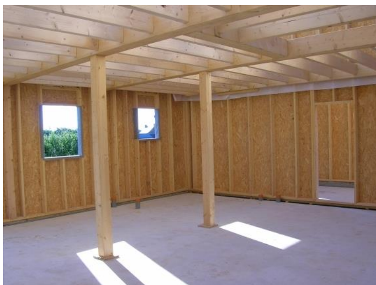
Figure 3-2 : Maison à ossature bois
