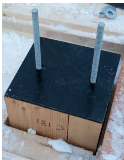
Figure 4-4 : Exemple d'assemblage Bois/Métal (A gauche [13] et à droite [11])
