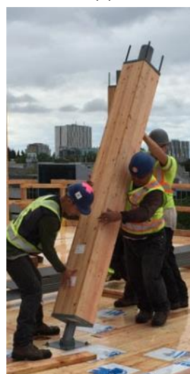
Figure 4-4 : Exemple d'assemblage Bois/Métal (A gauche [13] et à droite [11])
