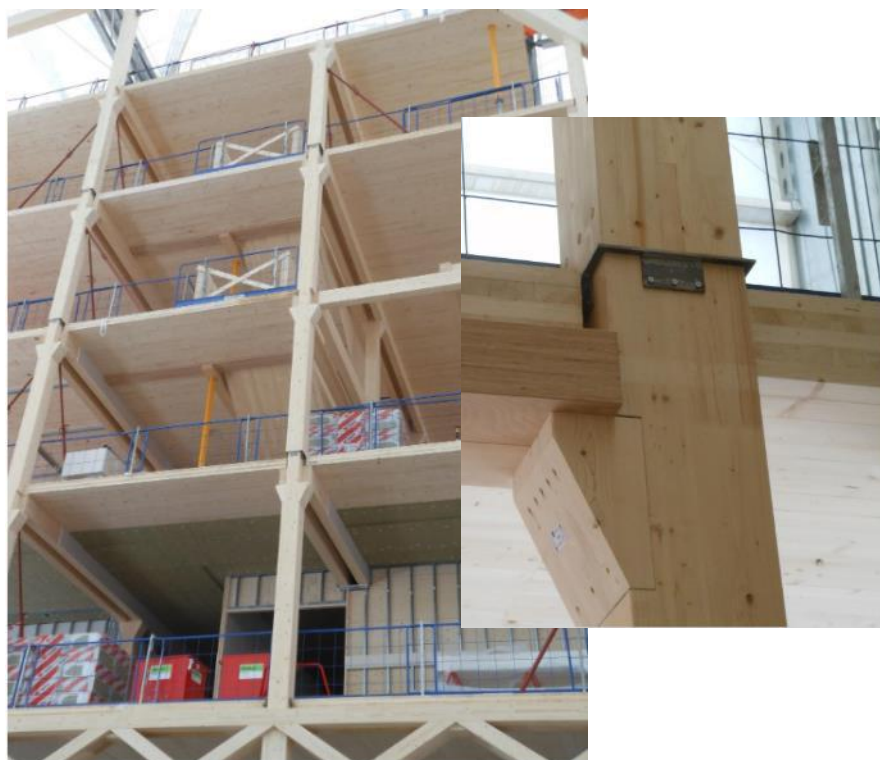
Figure 4-3 : Exemple d'assemblage Bois/Métal [17]
