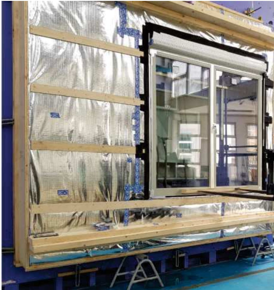
PHOTO N°7 – Objet B – Vue intérieure – Mise en œuvre de la bande adhésive SIGA Fentrim 20 entre la menuiserie et le pare vapeur
