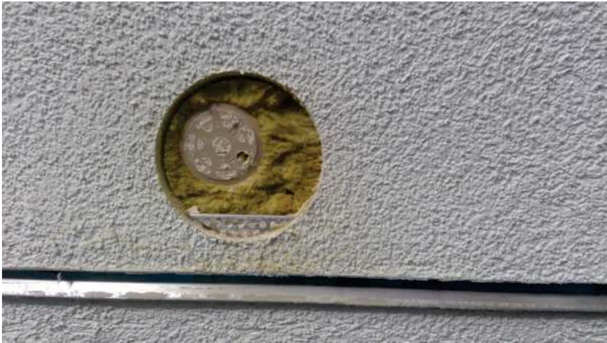
PHOTO N°8 – Objet B – Carrotage du mur à la fin de l'essai AEV
