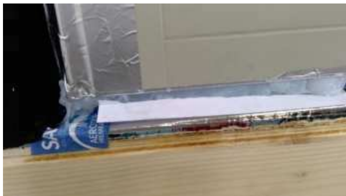
Au droit du montant à gauche
