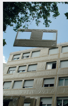
Levage des panneaux.
