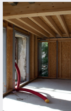
Ossature bois intérieure.
