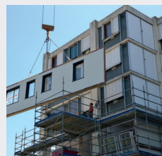
Levage des façades autoporteuses.
