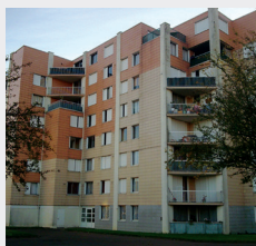
Avant réhabilitation : on distingue les poteaux béton largement dimensionnés.
