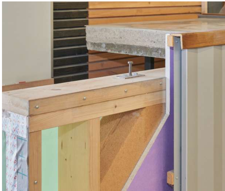
Guillaume Tondou, pilote opérations JO, présente le prototype de mur à ossature bois du lot PB10 avec plancher béton coulé en place, sous avis chantier
