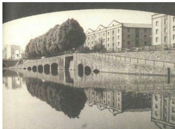
L'accès se faisait par voie fluviale.
