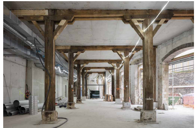
La structure poteau-poutre bois existante en cours de renforcement.
