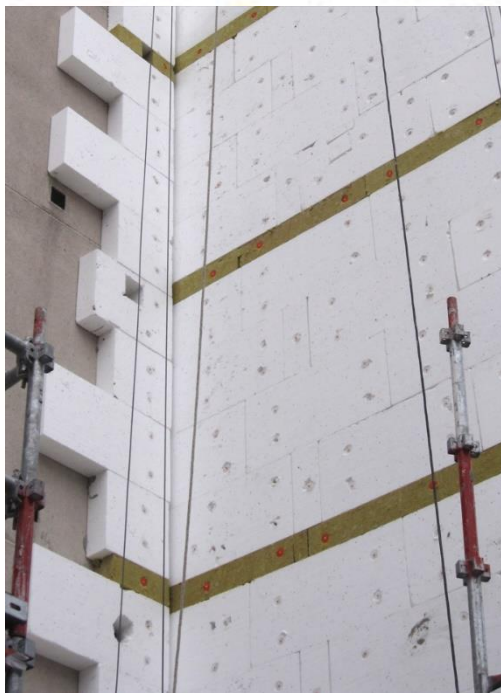
Figure 2 : protection incendie par bandes filantes incombustibles (crédit : [5])
