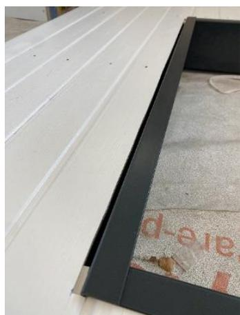
Photo 3 : Lame d'air en partie supérieure de l'encadrement avec baie
