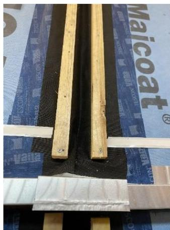
*Photo 6 : Eclisse pour assurer la continuité de l'étanchéité de la bavette horizontale*
