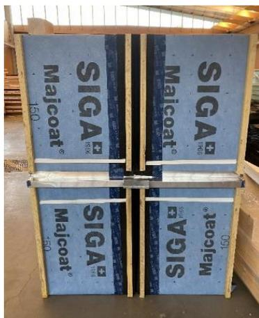
*Photo 5 : Pose des tasseaux bois au droit des montants et de la bavette*
