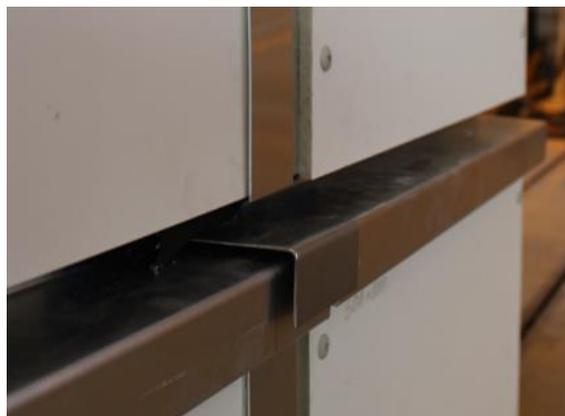
*Photo 5 : Eclisse pour assurer la continuité de l'étanchéité de la bavette horizontale*
