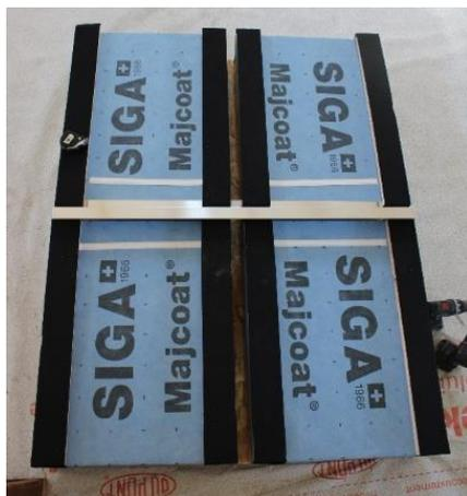
*Photo 4 : Pose des tasseaux bois au droit des montants et de la bavette*
