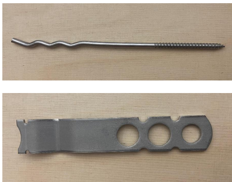
Figure 3 : Attache filaire (haut) et plate avec casse-goutte (bas)
