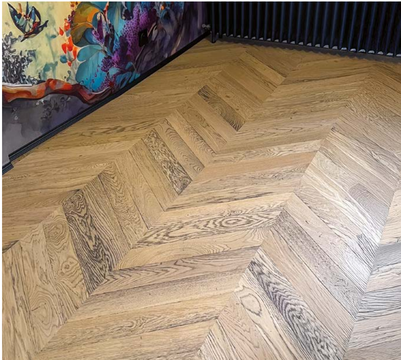
Singularités du chêne Gamme Écho* de la parqueterie Beau Soleil. Une collection de parquets issus de chênes dépérissants de la région Bourgogne Franche-Comté. Teintés naturellement à l'aide d'une infusion d'écorce, ils sont structurellement aussi denses, résistants et durables que les parquets de chêne classiques. Seule leur esthétique diffère, avec la présence de petits trous comme sur les vieux meubles.
