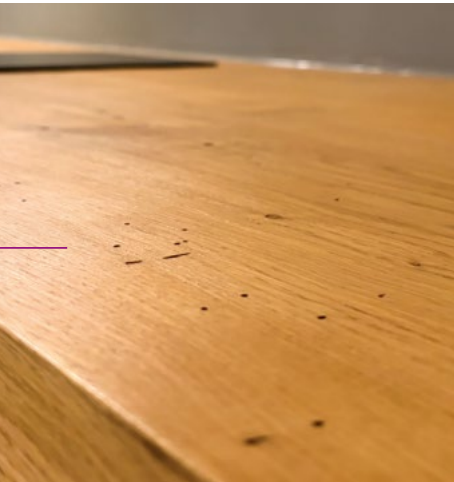
Piqûres et veinage brun d'un plan de travail en chêne du Bed and Breakfast "La Maison de Margaret" à Cluny (71).
