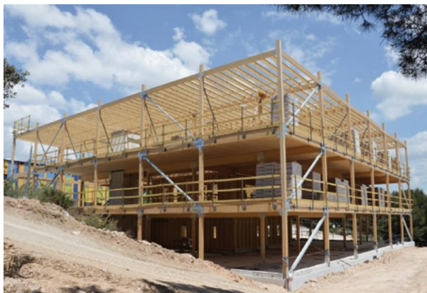
Toiture en poutres en I de l'EREA 1 Louis Aragon aux Pennes-Mirabeau (13). Architecture et crédit image : Apache Architectes / Frédéric Nicolas.
