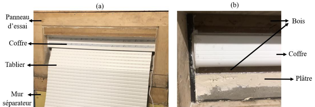
Figure 1.14 - Essai expérimental du coffre de volet roulant (a) du point de vue de la chambre d'émission et (b) de la chambre de réception, d'après [23]
